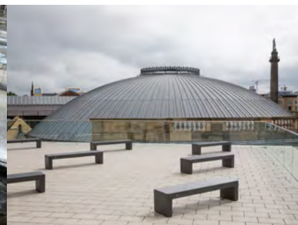
Das Dach nach der Renovierung
