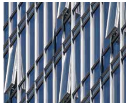
Bei Senkklappfenstern sind Flügelhöhen bis zu 2.500 mm umsetzbar
