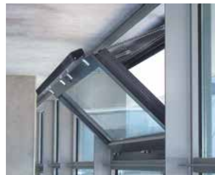
Kettenantriebe mit integriertem Funkempfänger können über eine Fernbedienung einzeln oder in Gruppen angesteuert werden
