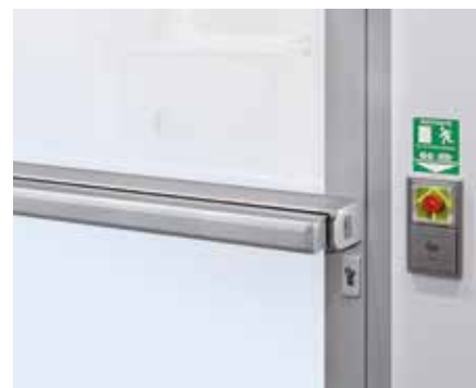
Fluchttürsteuerung FTNT kann als BKS-NET-fähiges Produkt in die Visualisierung eingebunden werden
