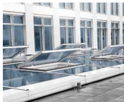
Dachfensteröffnung mit Spindelantrieb
