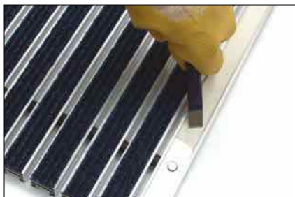
Wichtig: Schmutz, Rips und Klebereste vom Aluprofil entfernen (z. B. mit einem Stechbeitel).
