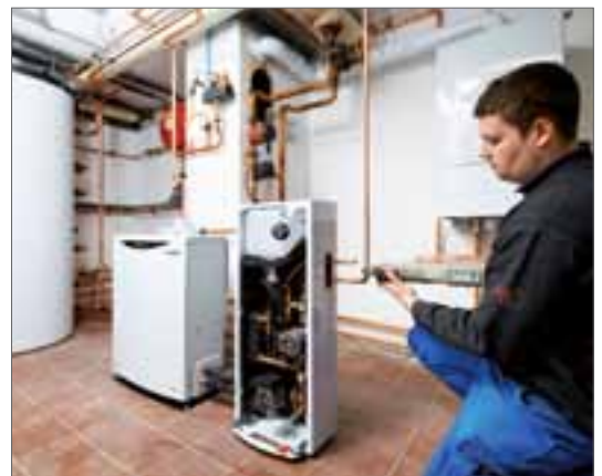
Innovativer Mix: Wärmespeicher, Erdgas-Mikro-BHKW, Wärmeauskopplungsmodul und Gasbrennwert-Heizgerät.
