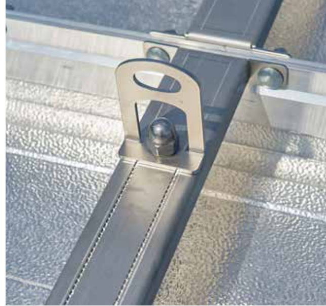
Zubehörkomponenten, wie oben abgebildete Absturzsicherung, lassen sich ohne Perforierung auf dem Profilbahnsteg mittels systemeigener Klemmlaschen befestigen.
