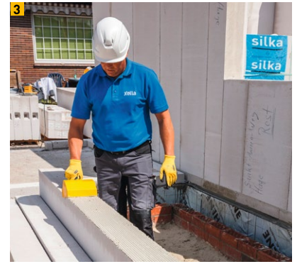
3 Vermörtelung der Stoffuge am liegenden Systemwandelement mit Dünnbettmörtel
