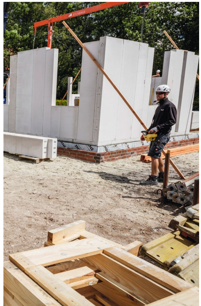
6 Jedes 4. Element mit Montagestütze sichern
