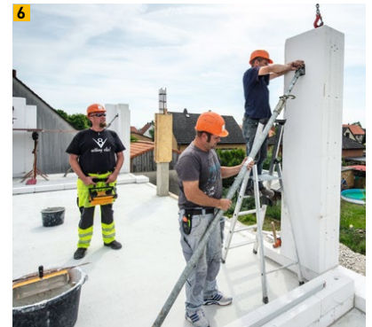
6 Jedes 4. Element mit Montagestütze sichern
