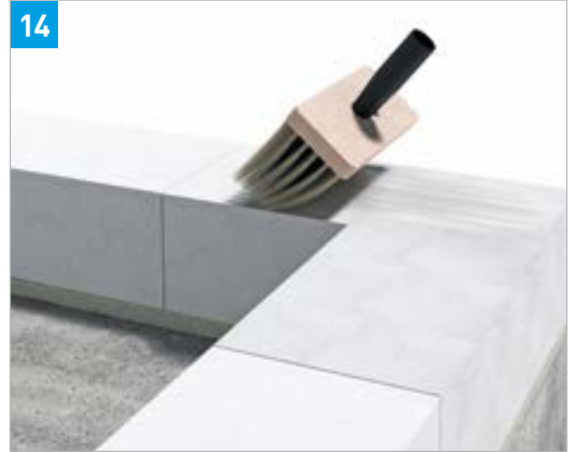
Bei Bedarf im Sommer gleichmäßig Vornässen
