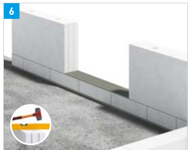
Ecksteine setzen und ausrichten
