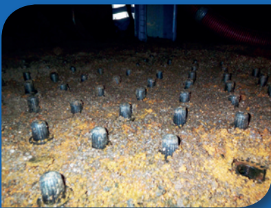
Behälter/Filterboden nach Entleerung mit starken Filtermaterialverbackungen im Düsenbereich
