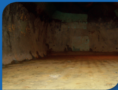
Behälter komplett entleert vor Sandstrahlen und Neubeschichtung
