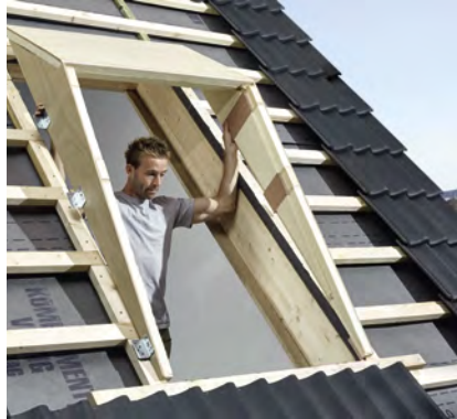
2. Dämmteile auf den vorbereiteten Dachausschnitt aufsetzen und mit der Unterkonstruktion verbinden.
