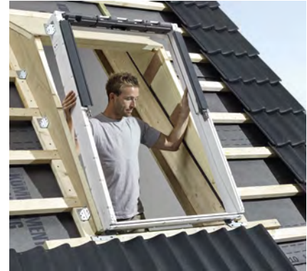
3. Fenster-Blendrahmen in die Dämmung einsetzen und verschrauben.
