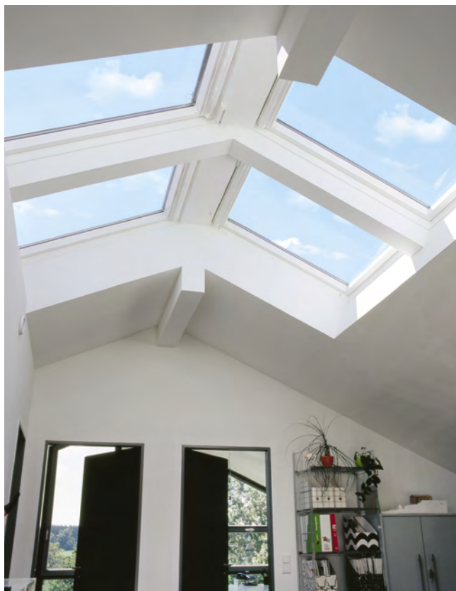
Abbildung zeigt 2 x 2 Dachfenster, die über den First eingebaut sind. Gesamtpreise unten beziehen sich auf 1 x 2 Dachfenster.
