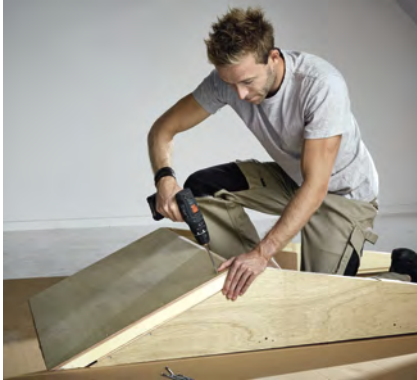
1. Die im Lieferumfang enthaltenen Dämmteile montieren.
