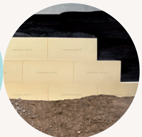
Perimeterdämmung Kelleraußenwand mit URSA XPS
