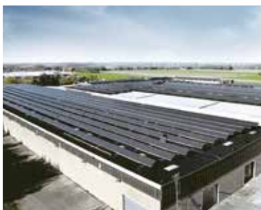
Spedition Nosta, Piding (DE) • Bauteil: Solardach • Objektgröße: 25.000 m 2 • Fertigstellung: 2009
