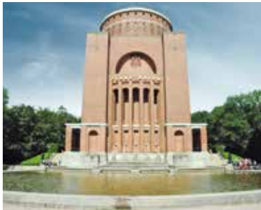
Planetarium, Hamburg (DE) • Bauteil: Wasserbecken • Objektgröße: 110 m 2 Überläufe, 250 m 2 Beckenrand • Fertigstellung: 2011
