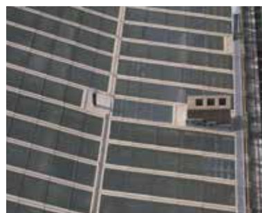
Pergamonmuseum, Berlin (DE) • Bauteil: Glasdach • Objektgröße: 1.800 m 2 • Fertigstellung: 2004
