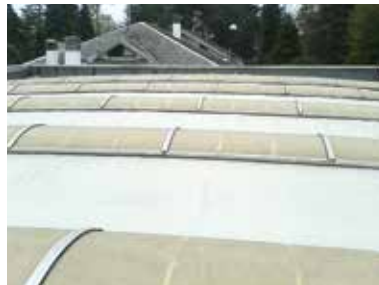
Werkshalle, Besnate (IT) • Besonderheit: Bogenförmiges Dach • Objektgröße: 900 m 2 • System: Triflex ProTect • Fertigstellung: 2014
