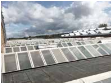
Sheddach Industriehalle, Braunschweig (DE) • Besonderheit: Glasabdeckung • Objektgröße: 4.000 m 2 • System: Triflex ProDetail • Fertigstellung: 2016
