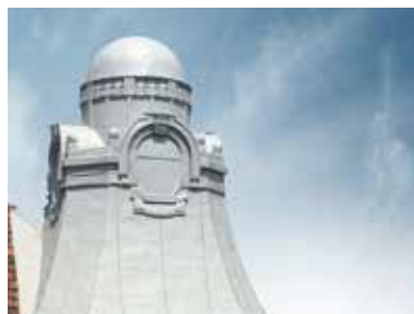
Türme Apartmenthaus, Wien (AT) • Besonderheit: Denkmalgeschützte Blechdächer • Objektgröße: 2 x 180 m 2 • Systeme: Triflex ProDetail, Triflex ProFibre, Triflex MetalCoat • Fertigstellung: 2015
