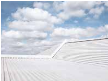
Metалldach Industriehalle, Pirmasens (DE) • Besonderheit: Metалldach • Objektgröße: 1.400 m 2 • Systeme: Triflex ProDetail und Triflex Metal Coat • Fertigstellung: 2014
