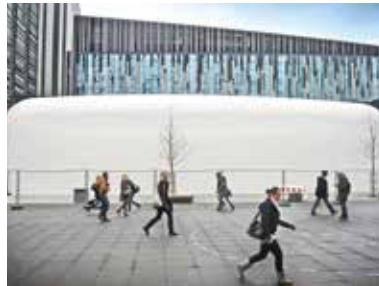
Auditorium Maximum Universität, Leipzig (DE) • Besonderheit: Gewölbtes Dach mit homogener Oberfläche • Objektgröße: 1.400 m 2 • Systeme: Triflex ProTect und Triflex ProDetail • Fertigstellung: 2013
