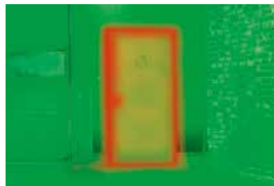
Sichtbarer Energieverlust ohne thermisch getrennte Tür
