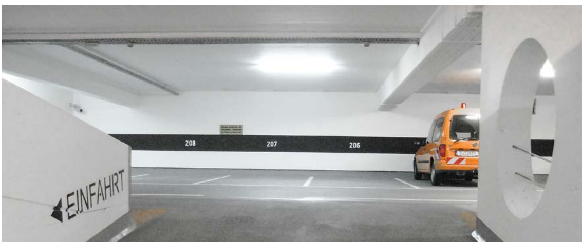
Parkhaus West, Überlingen, DE StoCretec-Kompetenzen: StoConcrete Carbon Plate, StoConcrete Screed Classic TG Foto: StoCretec GmbH
