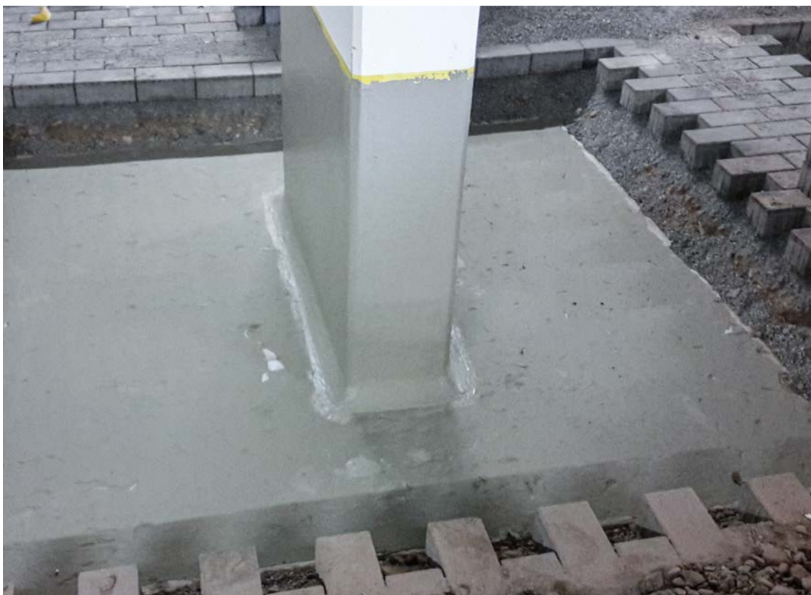
Bild links: StoConcrete Protect Elastic FB dichtet überschüttete Bauteile unter Pflasterbelägen ab und schützt im Sprüh- und Spritzbereich die Bausubstanz. Foto: StoCretec GmbH
