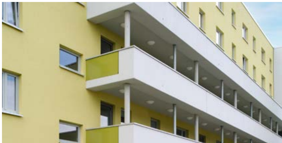
Mehrfamilienhaus, Greifswald, DE StoCretec- Kompetenzen: StoFloor Balcony Elastic EB 200, Tragwerksver- stärkung mit Sto SGP CFK-Lamellen Foto: Maximilian Meisse, Berlin
