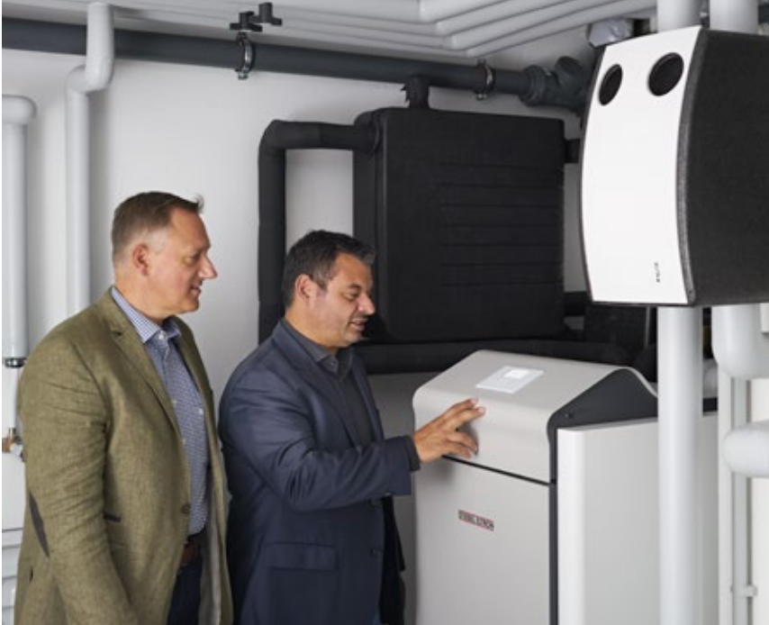
Installateur Felice Cuffaro (rechts) und STIEBEL ELTRON-Fachmann Ralf Könen an der Erdreich-Wärmepumpe WPE-I 06 HK 230 Premium.
