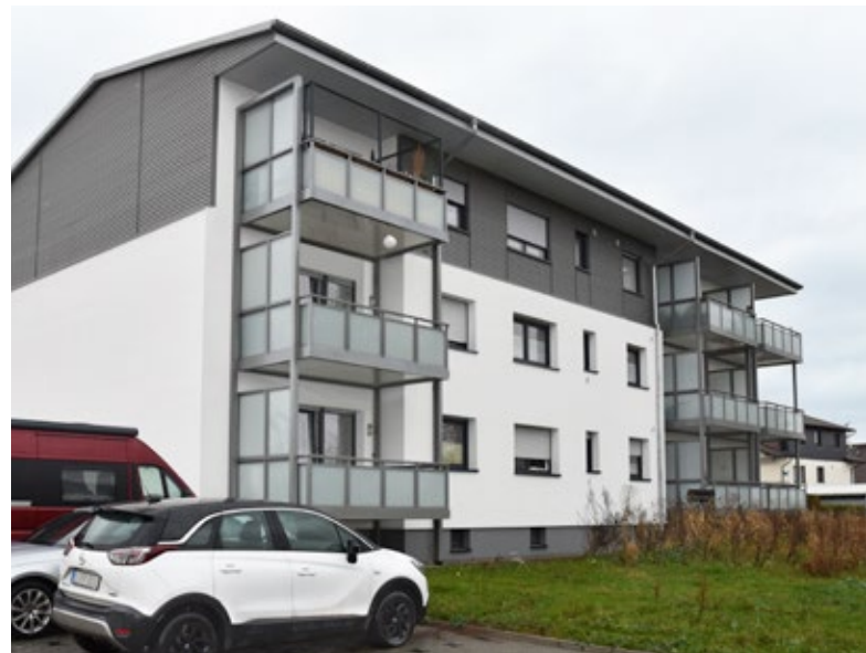
Das bestehende Gebäude wurde um ein Geschoss aufgestockt und unter anderem die Fassade mit neuem Wärmedämmverbundsystem ausgestattet.
