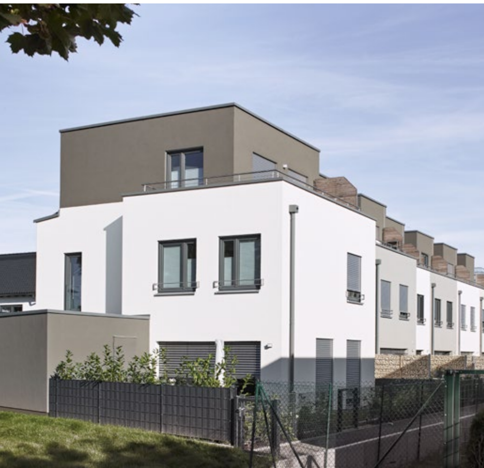
Die versetzte Anordnung der Baukörper lockert die Ansicht auf.
