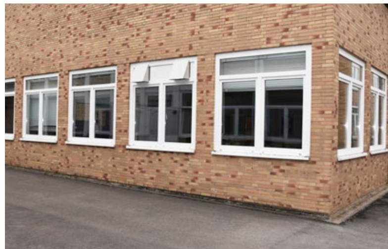
Einfache Installationslösung: Austausch eines Oberlichts gegen ein Paneel, in das die beiden Öffnungen für Zu- und Abluft integriert sind.
