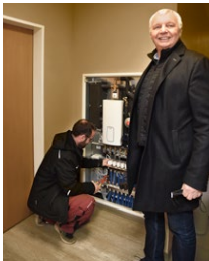
Installateur Kim Buttron an der Wohnungsstation, in der auch der Durchlauferhitzer für die eventuelle Nacherwärmung des Warmwassers integriert ist. Im Vordergrund der Geschäftsführer der Wohnungsbaugenossenschaft, Holger Frutig.
