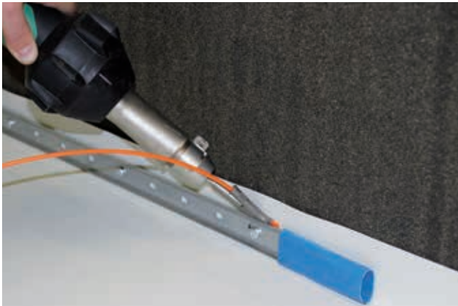
Randfixierung mit FLAGON Befestigungsschiene
