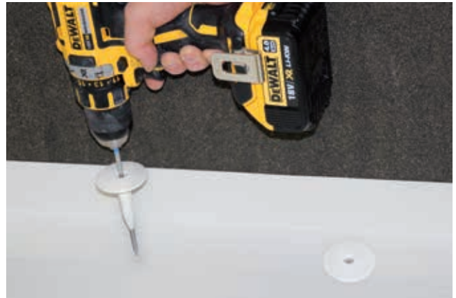
Lineare Befestigung mit Einzelbefestigern (nur vertikal in den Untergrund zulässig)
