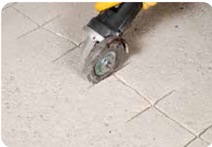
1. Öffnen des Risses und Einschneiden von Kanälen zur Querfixierung.
