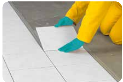
4. Eine anschließende Verlegung von kerami-schen Belägen kann z.B. mit weber.xerm 861 durchgeführt werden.
