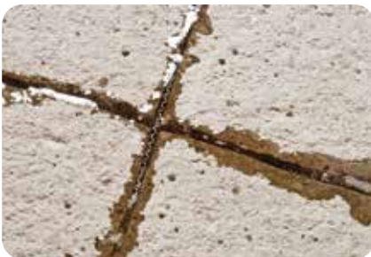
2. Vertiefungen ggf. mit gefülltem oder ange-dicktem Harz nachspachteln. In die noch klebrige Harzschicht zur Haftvermittlung trockenen Quarzsand ca. 0,3–0,8 mm im Überschuss einstreuen.
