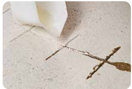
1. Die Risse und Kanäle werden mit weber.prim 806 oberflächenbündig verfüllt.
