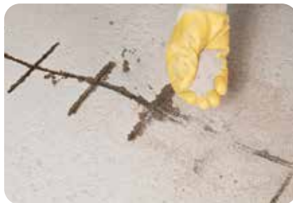
3. Nach vollständiger Aushärtung muss der lose Überschuss-Sand restlos entfernt werden. Wenn nötig, können die Estrich- oder Betonflächen z.B. mit weber.plan 813-25 ausgeglichen werden.
