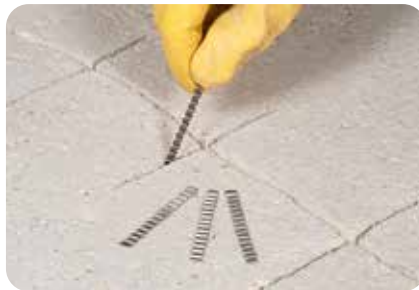
2. Nach gründlicher Entfernung von Staub und anderen haftungsmindernden Bestandteilen werden Rissfixierungsklammern in die Querkanäle eingesetzt.
