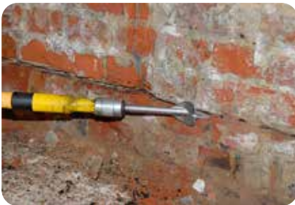
1. Alter, nicht tragfähiger Putz wird komplett abgeschlagen.
