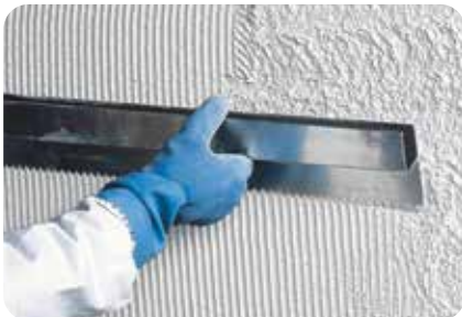
1. Zum Egalisieren von weber.top Edelkratzputzen wird eine gezahnte h-Kartätsche empfohlen.
