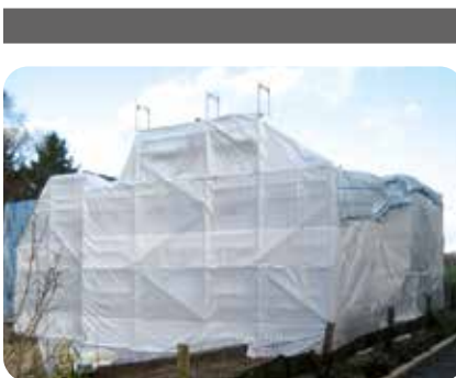
2. Eingehauste Gerüste können abbindende Putze vor äußeren Einwirkungen schützen, beschleunigen aber nicht zwangsläufig die Trocknung der Putze.
