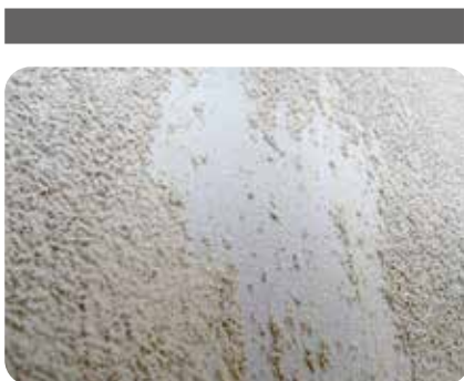
1. Schlechte Witterung – auch wenn sie erst nach der Verarbeitung einsetzt – kann das Abbinden erheblich verzögern. Dies kann auch mehrere Tage nach der Verarbeitung zu Schäden am Putz führen.
