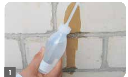
1. Saugverhalten prüfen, ggf. vornässen; Putzgrund auf Tragfähigkeit prüfen
