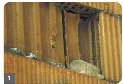
1. Putzgrund auf Tragfähigkeit prüfen.
