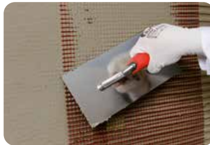
2. Zum Eindrücken des Armierungsgewebes wird ein Glätter/Traufel benötigt.
