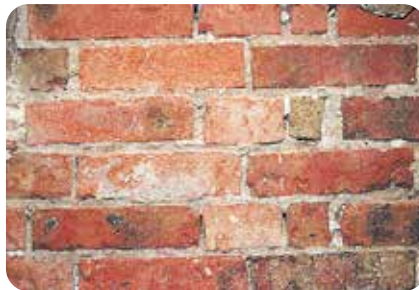
2. Nicht tragfähige Fugen auskratzen.
