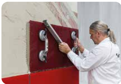
20. ... und planeben exakt ausrichten.
