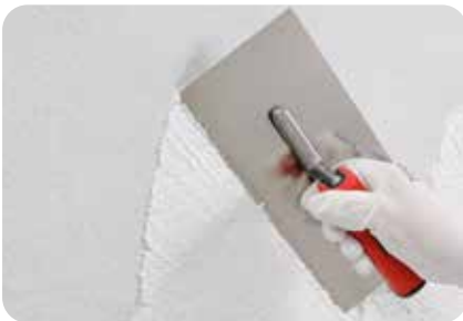
1. Oberputz mit einem Glätter/Traufel aufziehen.
