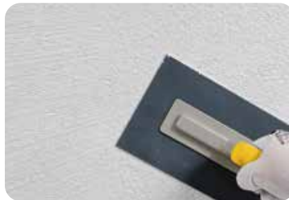
2. Oberputz mit einem Kunststoffglätter strukturieren.
