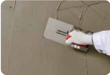
1. Zum Auftragen einen Glätter/Traufel einsetzen.
