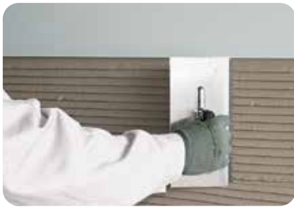
16. Bei Kleberauftrag auf der Wand gewährleistet die Spitzzahnkelle Nr. 2 eine optimale Klebverteilung auf der gesamten Fläche.
