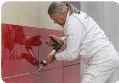
23. Die Fugen der Glaselemente werden mit Ottoseal S 110 versiegelt.
