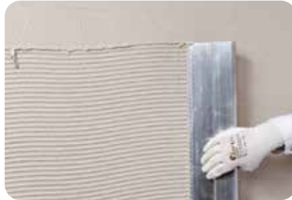
2. Zum Zuziehen eine Zahnkartätsche verwenden.
