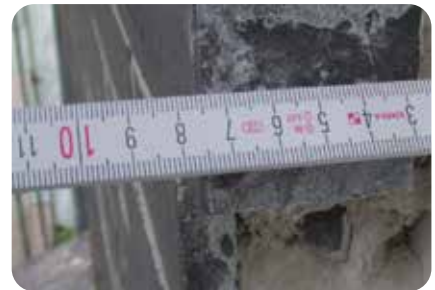
3. Sparverblender I ( d = 55 bis < 90 mm) im Mörtelbett auf tragfähigem Untergrund
