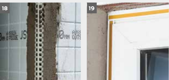
WDVS mit EPS-Dämmplatte und dickschichtigem, mineralischem Putzaufbau
