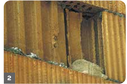
2. Schließen der Mörteltaschen mit geeignetem Material, z.B. mit Leichtputz weber.dur 132 . Ausbrüche und Mörteltaschen müssen vor dem eigentlichen Verputzen geschlossen werden. Nach dem Schließen muss eine ausreichende Standzeit (1 Tag/mm Auftragsdicke) eingehalten werden.
