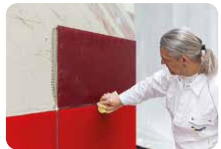
21. Direkt nach der Verlegung sind Fugen und Gläser von Kleberesten zu reinigen.
