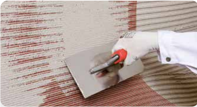
Die Einbettung eines Armierungsgewebes erhöht die Zugfestigkeit
