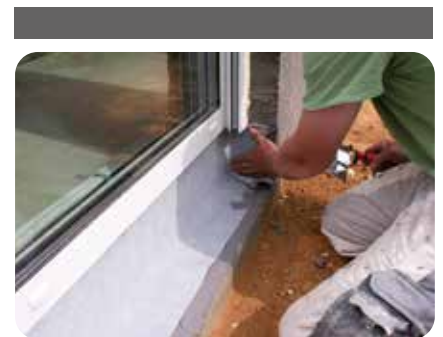
3. Eindichten des Türanschlusses mit z.B. weber.tec Superflex D 24/weber.tec Superflex D 2 . Die Abdichtung wird überlappend auf den unteren Türholm sowie auf die Wandleibungen aufgebracht. Die erste Lage wird zur Verstärkung vollflächig in weber.sys 982 Dichtfolie eingearbeitet.
