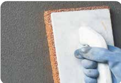
4. Zum Durchreiben der weber.therm Armierungsmörtel z.B. für Faschen, wird ein Schwammbrett empfohlen.
