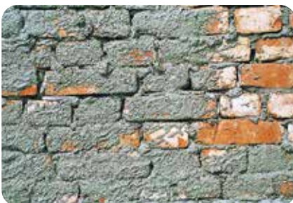
4. Das Mauerwerk mit einem voll deckenden Spritzbewurf z.B. weber.therm 500 oder weber.san 160 WTA vorspritzen.
