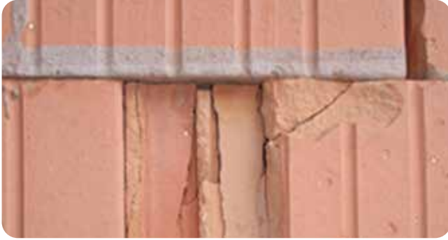
Qualität des Mauerwerks
