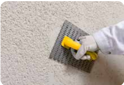
2. weber.top Edelkratzputze werden mit einem Kratzbrett gekratzt.
