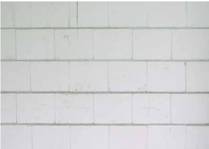
1. Saugverhalten prüfen, ggf. vornässen; Putzgrund auf Tragfähigkeit prüfen
