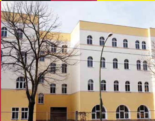
WDVS mit EPS-Dämmplatte und dickschichtigem, mineralischem Putzaufbau
