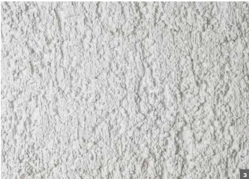
Bild 3: Schlepp- und Rappputz-Struktur
