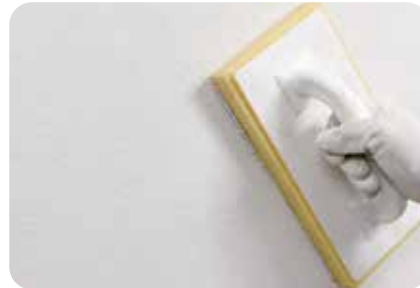
5. Zum Abreiben oder Abfilzen des Unterputzes ein Schwammbrett verwenden.
