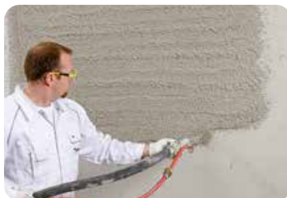
5. Bis zu einer Dicke von 40 mm wird der Wärmedämmputz z.B. weber.therm 505 einlagig, bei größeren Dicken bis 100 mm mehrlagig aufgebracht.
