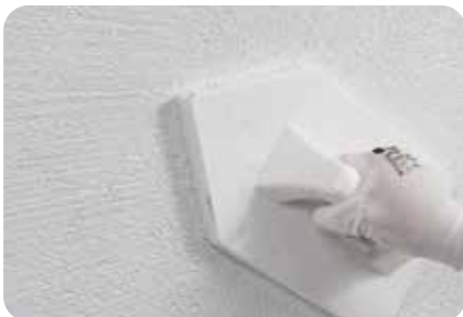
4. weber.star Edelputze werden mit einem Kunststoffglätter oder Styropor-Reibebrett gerieben bzw. geschleibt.
