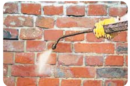
3. Die komplette Fassade reinigen.
