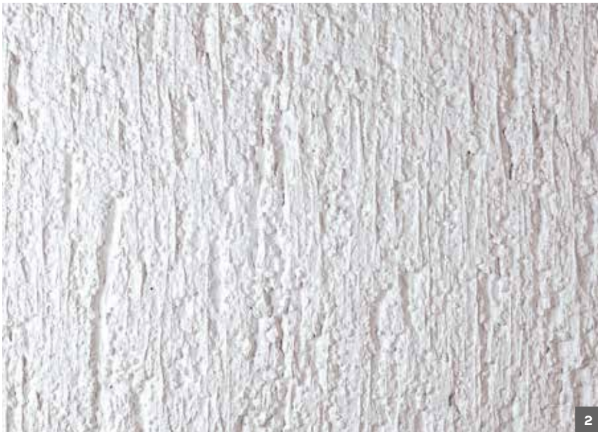
Bild 2: Schlepp- und Rappputz-Struktur
