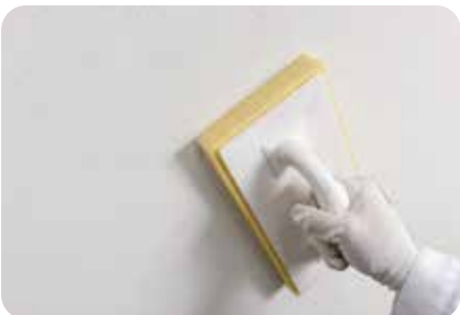
5. Filzputze, z.B. weber.star 295 , werden mit einem Schwammbrett gefilzt.
