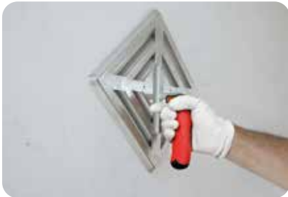
4. Zum Egalisieren wird ein Rabbospeed empfohlen.
