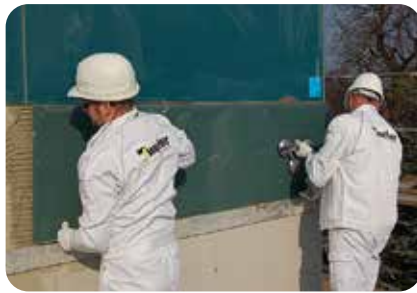
17. Die Glaselemente müssen unverzüglich nach Kleberauftrag montiert werden. Bei großen Elementen erleichtern Stützkonstruktionen oder Keile das exakte Positionieren
