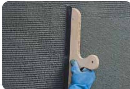
5. Zum Entfernen der Sinterhaut wird ein Flächenspachtel, gezahnt , benötigt.
