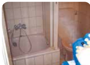
15. Im Anschluss wird die Vernebelung unter Berücksichtigung des Arbeitsschutzes durchgeführt. Nach entsprechender Einwirkzeit ist gründlich zu lüften. Danach können die Räume wieder betreten werden.
