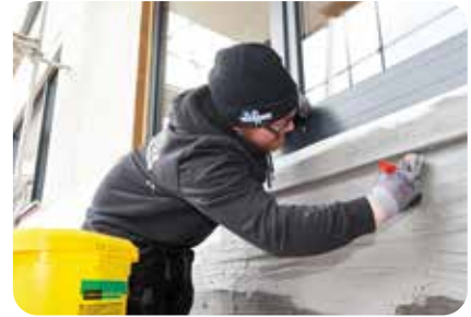
9. Fertig eingedichteter Detailpunkt.
