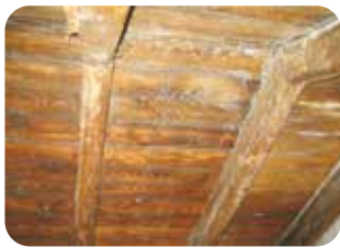
9. Massive Holzbalkendecke nach der Behandlung und Säuberung.
