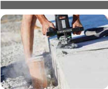
1. Untergrundvorbereitung: Entfernen von haftungsmindernden Bestandteilen.
