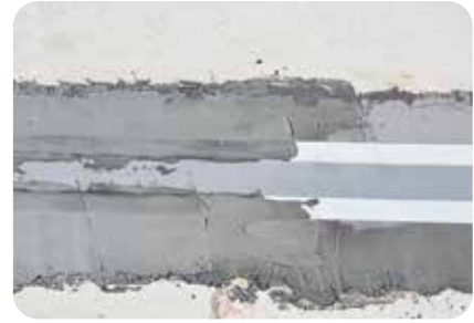
6. weber.tec Superflex B 240 Fugenabdichtband wird frisch-in-frisch in die erste Lage der Reaktivabdichtung eingebracht. Das Vlies wird vollständig eingearbeitet. Sobald die erste Abdichtungslage nicht mehr beschädigt wird, erfolgt der Auftrag der zweiten Abdichtungslage.
