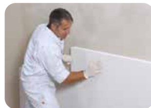
16. Nach ggf. erforderlicher Freimessung kann mit dem Wiederaufbau, z.B. mineralisches, schimmelpilzhemmendes Weber Innendämmsystem , begonnen werden.
