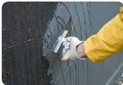
5. Schichtdickenkontrolle durch Anwendung der Schichtdickenkelle bei der Verarbeitung von webertec Superflex D 24.
