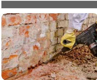
2. Ausstemmen einer Nut im Bereich Boden/Wandanschluss.
