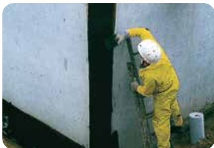
7. Auftragen der Fugenabdichtung weber.tec Superflex 10 im Bereich der senkrechten Elementstoßfuge.
