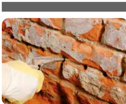
5. Bohrlöcher mit ölfreier Druckluft ausblasen.
