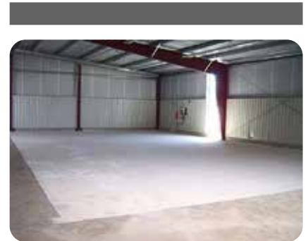
3. Fertige Bodenfläche nach Untergrundvorbereitung durch Kugelstrahlen.
