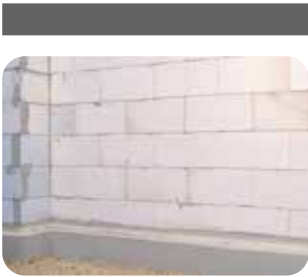
1. Gereinigter, vollfugiger, tragfähiger Untergrund, Kanten sind zu brechen.
