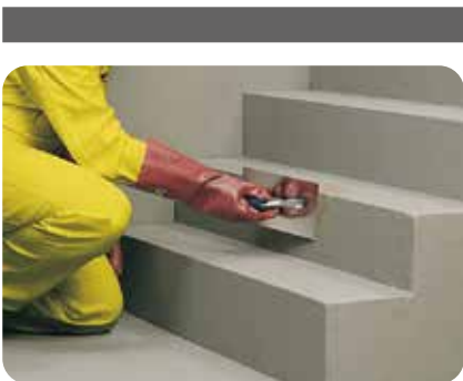
4. Reparatur von Ausbruchstellen an Betonfertigteiltreppen mit weber.rep R4 duo .
