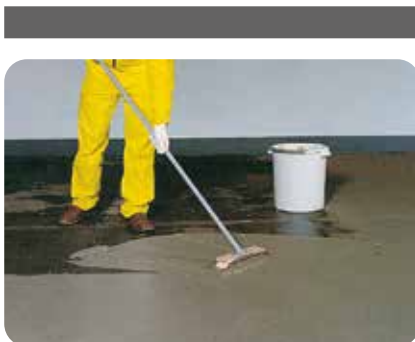
4. Die Haftbrücke weber.rep KB duo wird kräftig in den mattfeucht vorgeässten Untergrund einarbeitet.
