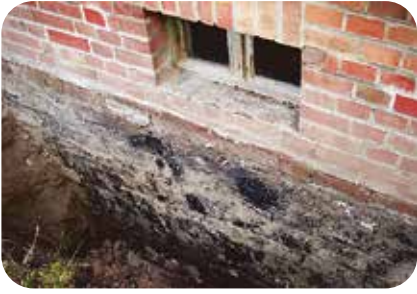
7. Bei Altbitumenuntergründen empfehlen wir den Einsatz von weber.tec Superflex D 24 oder weber.tec Superflex 10 .
