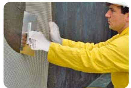
3. Kontrolle der Auftragsdicke durch Einbettung des weber.sys 981.
