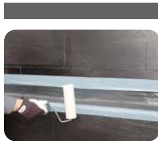
7. Um den vollflächigen Verbund zum Untergrund sicherzustellen, wird die Dichtbahn anschließend flächig und insbesondere im Bereich von Stößen und Übergängen fest angerollt.
