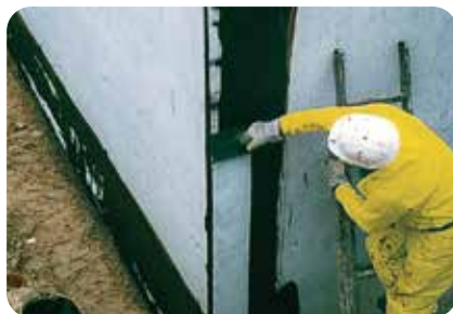
8. Einarbeiten der Verstärkungseinlage weber.sys 981 im Bereich der Elementfugen.
