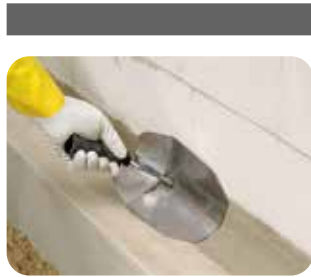
2. Ausrunden der Kehlen und senkrechten Innenecken mit weber.tec 933 .
