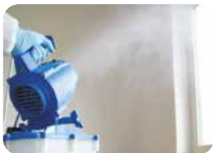
13. Im Anschluss erfolgt die Behandlung der Raumluft. Dazu wird ein Sporenreiniger mit Hilfe von speziellen Vernebelungsgeräten (sog. Kaltfogger) in der Raumluft fein verteilt. Das Produkt inaktiviert die in der Raumluft schwebenden Sporen und Partikel.
