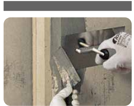
3. Kantenausbrüche werden mit weber.rep R4 duo repariert.
