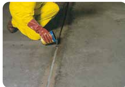
9. Der chemikalienbeständige Fugenverguss, erfolgt mit der elastifizierten Industriefuge weber.tec 977 .
