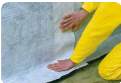
13. Ausführung einer Schutz- und Dränschicht aus weber.sys 983 auf der durchgetrockneten Flächenabdichtung.
