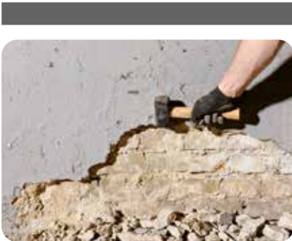
1. Altputz bis mind. 80 cm oberhalb der schadhaften Zone abschlagen.
