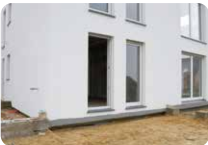
10. Ansicht der WDVS-Fassade nach Fertigstellung der Türschwelledetails.
