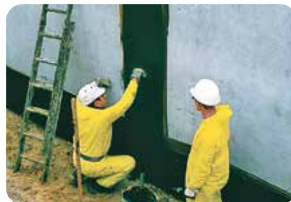
9. Überarbeiten der Verstärkungseinlage aus weber.sys 981 mit weber.tec Superflex 10 .
