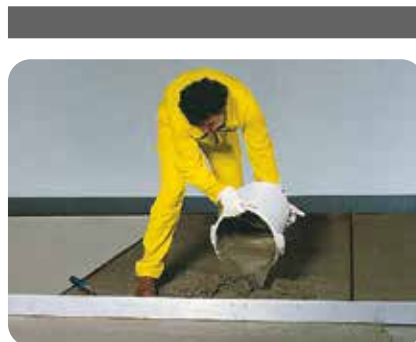
5. Der Betonersatzmörtel weber.rep 752 , für Schichtdicken von 10 bis 40 mm, wird in die noch frische Haftschlämme aufgebracht. Für Schichtdicken von 25 bis 100 mm eignet sich weber.rep 753 .
