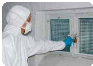
14. Vor der Anwendung des Sporenreinigers sind Fenster und Türen der Räume dicht zu verschließen.
