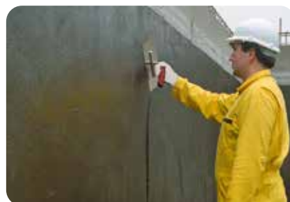
12. Überarbeiten des Glasseidengewebes mit weber.tec Superflex 10 .
