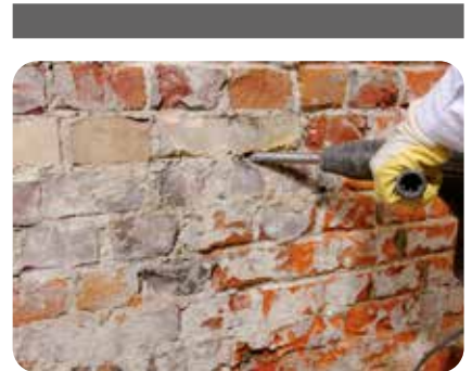
3. Mauerwerksfugen bis in ca. 2 cm Tiefe ausräumen.
