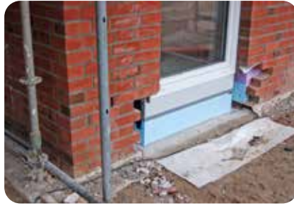
8. Im Bereich bodentiefer Fenster bzw. Türen ist die Vorsatzschale im unteren Bereich auszusparen.
