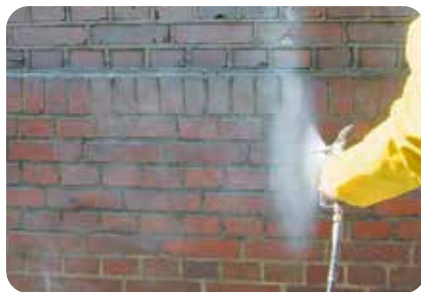
8. Auftragen der Fassadencreme weber.tec 775 mit dem Airlessgerät.
