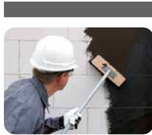
3. Auftragen der Grundierung aus weber.tec 913 VE , unterhalb von + 5°C bis -5°C aus weber.tec 902 .
