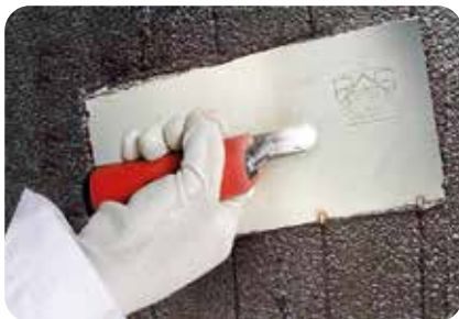
4. Schichtdickenkontrolle durch Anwendung der Schichtdickenkelle bei der Verarbeitung von webertec Superflex 10.
