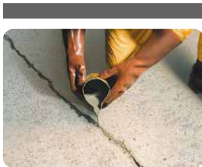
5. Risse in Betonfertigteilen werden mit weber.prim 806 , schnellabbindendes, 2-komponentiges Epoxidharz, vergossen. Sollten Fugen zwischen Betonbauteilen elastisch verschlossen werden müssen, so empfehlen wir die Verwendung von weber.tec 977 Industriefuge in Kombination mit Hinterfüllmaterial zur Vermeidung von Dreiflankenhaftung.
