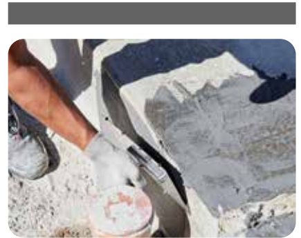
3. Kratzspachtelung aus weber.tec Superflex D 24.
