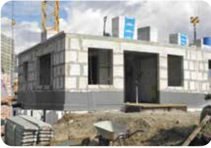
7. Ansicht des fertig abgedichteten Sockels am Fußpunkt und am Hintermauerwerk.
