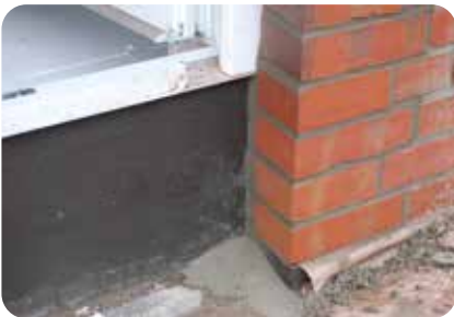
10. Im Nachgang wird dann die Vorsatzschale komplettiert.
