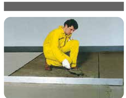
6. Danach wird der Betonersatzmörtel abgezogen und verdichtet.
