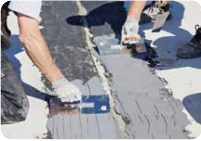
4. Aufbringen der ersten Abdichtungslage weber.tec Superflex D 24.
