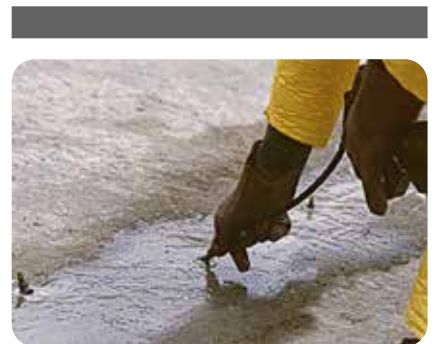
6. Das Verpressen von Rissen erfolgt mit weber.tec 945 , 2-Komponenten-Reaktionsharz auf Epoxidharzbasis. Das Reaktionsharz besitzt eine hohe Kriechfähigkeit und baut eine gute Haftung zwischen den Rissflanken auf. Evtl. austretendes Harz wird mit ofengetrocknetem Quarzsand abgestreut.
