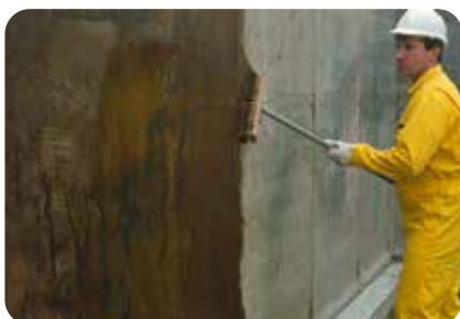
10. Grundierung der Betonflächen mit weber.tec 901 , 1 : 10 mit Wasser verdünnt.
