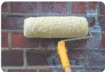
7. Auftragen der Fassadencreme weber.tec 775 mit der Rolle.
