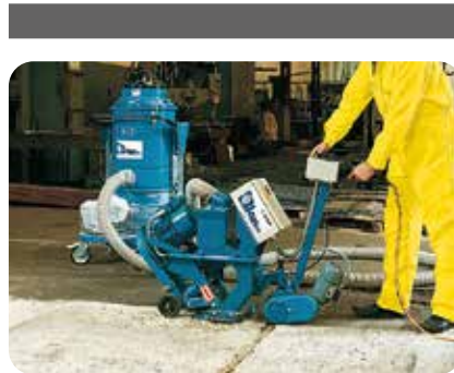
2. Dazu ist eine geeignete Untergrundvorbereitung, wie z.B. Kugelstrahlen, Fräsen oder Hochdruckwasserstrahlen, durchzuführen.
