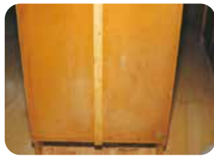
10. Auch schlecht belüftete Möbelerückseiten, z.B. Schrankrückwände, können von Schimmel befallen sein. Auch hier ist nach der Behandlung der Schimmelbefall zu entfernen.
