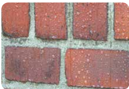
10. Klinkerfassade mit deutlicher wasserabweisender Eigenschaft, nach der Behandlung mit weber.tec 775 .
