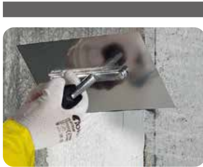
2. Der Auftrag des kunststoffvergüteten, schwindkompensierten und schnellabbindenden Betonfeinspachtel weber.rep 763 erfolgt in Auftragsdicken von ansatzlos bis 5 mm, verschnitten mit Sand bis 10 mm.
