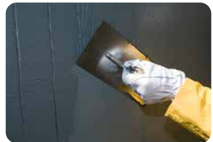
6. Glättspachtelung des mittels Schichtdickenkelle aufgetragenen Deckauftrages bei Verwendung von webertec Superflex D 24.
