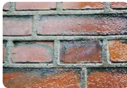
9. Fassadenoberfläche kurz nach dem Auftrag von weber.tec 775 mit dem Airlessgerät.
