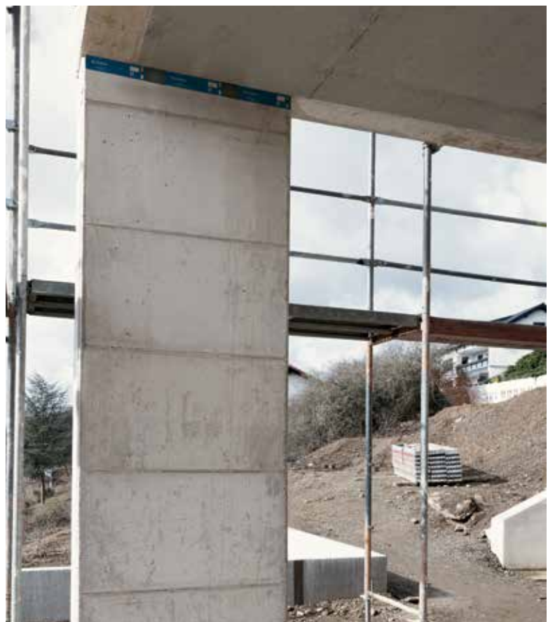
Schöck Sconnex® ermöglicht schlanke Wandvorlage in Sichtbetonoptik bei nachhaltig gelöster Wärmebrücke.
