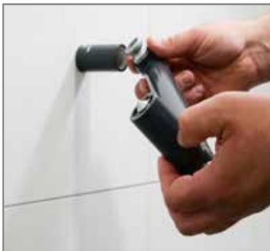
Der praktische Markierer (Dorn) hilft beim Anzeichnen.
