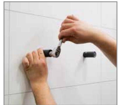
Zweites Anschlussstück montieren und ausrichten.
