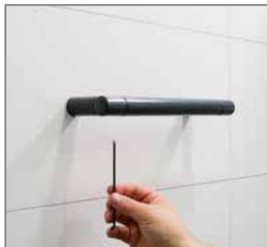
Gewindestifte eindrehen und anziehen.
