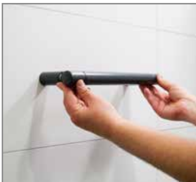
Aufsetzen des Griffrohrs auf die zwei montierten Anschlussstücke.
