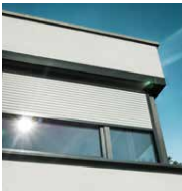
Vorbaurollladen QUADRO flächenbündig mit der Fassade montiert.
