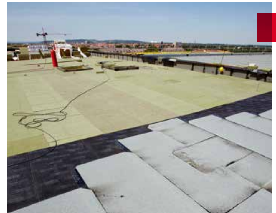
Lose Bestandteile werden zunächst von der alten Dachfläche entfernt.
