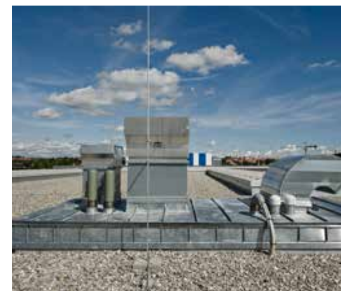
Dachaufbau lose verlegt mit Auflast
