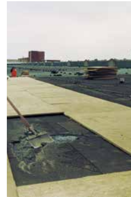
Lose Bestandteile werden zunächst von der alten Dachfläche entfernt.
