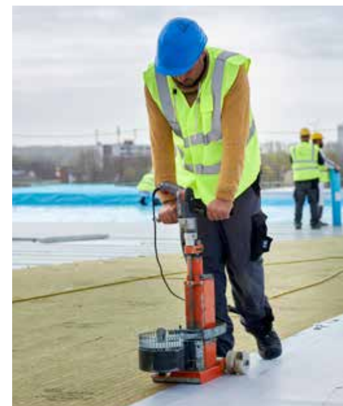
Dachaufbau mechanisch befestigt
