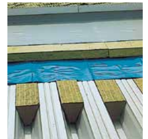
Brandschutz-Profilfüller zum Lastabtrag
