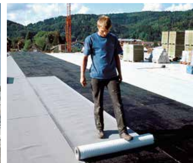
Dachaufbau verklebt
