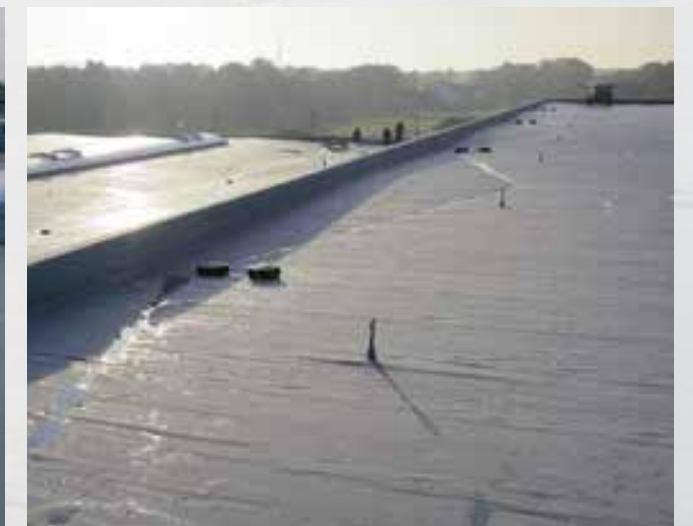
Punktentwässerung entlang der Attika
