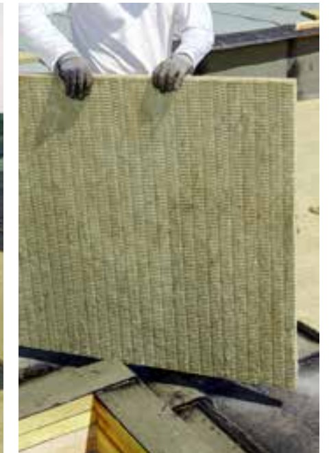
Verlegung der RP-TF auf ausgebessertem altem Dachaufbau
