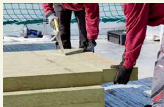
Die Dämmplatten lassen sich leicht zuschneiden.
