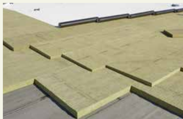
Die Verlegung der Dämmplatten erfolgt im Verband.
