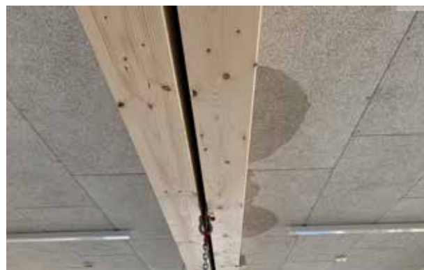
Undichter Modulstoß
