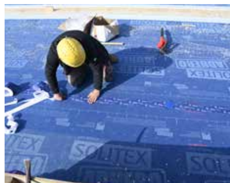
Zur Verklebung der Bahnen untereinander.
