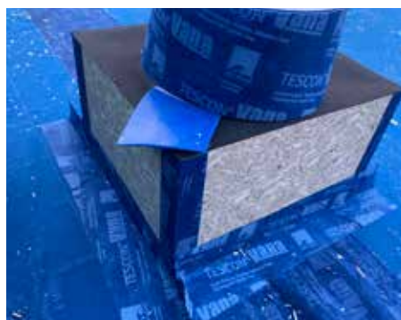
Zur sicheren Abdichtung von Durchdringungen
