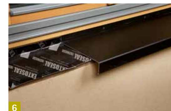
6 Fensterbank montieren
