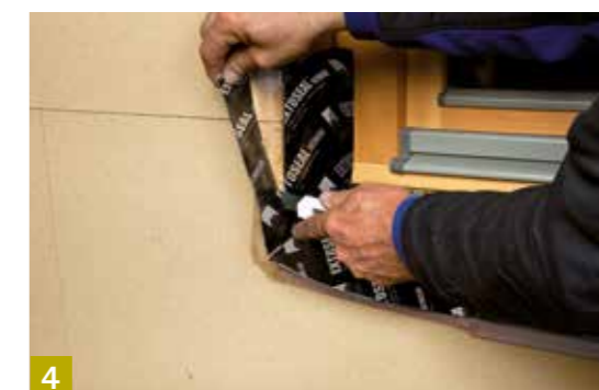
4 Senkrechte Überstände abschneiden
