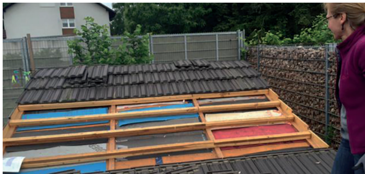
Untersuchung von frei gespannten Unterdach- bzw. Unterdeckbahnen verschiedener Hersteller 5 Jahre nach dem Einbau
