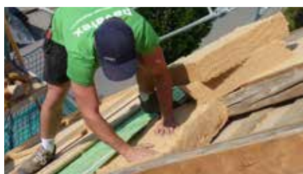
Abb. 2 Dachsanierung von außen ohne Beeinträchtigung des Innenraums.
