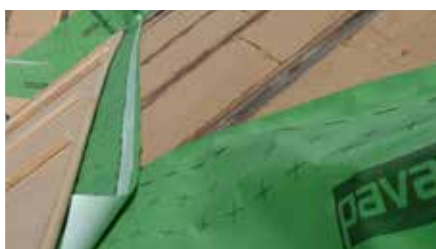
Abb. 2 Dachsanierung von außen ohne Beeinträchtigung des Innenraums.
