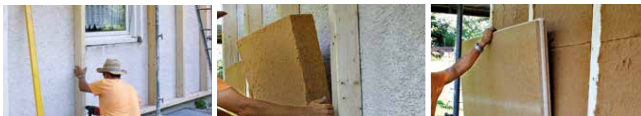
Abb. 2 Wandsanierung von außen:
