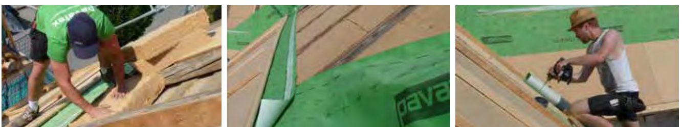
Abb. 17 Dachsanierung von außen ohne Beeinträchtigung des Innenraums.
