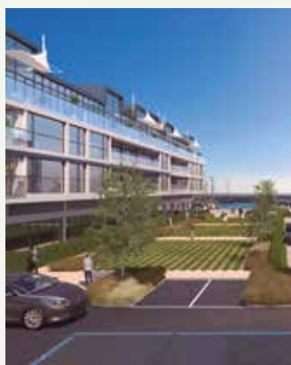
Marina Village in Greystones. Wohnkomplex mit 205 Wohnungen und 153 Häusern. Irland. Aquarea
