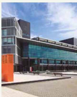
Technologiepark Andalusien in der Provinz Malaga. Bürogebäude mit hoher Energieeffizienz. Spanien. ECOi
