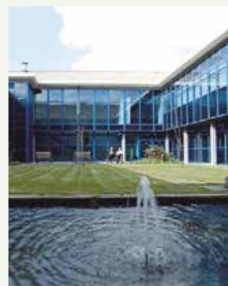
Canford House, Klinikgebäude des NHS. Bournemouth, Großbritannien. VRF
