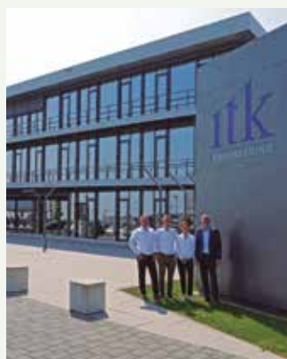
Innovatives Bürogebäude der ITK Engineering GmbH, Deutschland. ECOi und PACi
