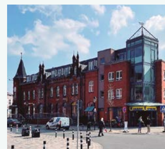
Erste EDEKA-Supermarktfiliale in Deutschland mit dem filterlosen nanoe™ X-Luftreinigungssystem ausgestattet, Deutschland. ECOi und nanoe™ X
