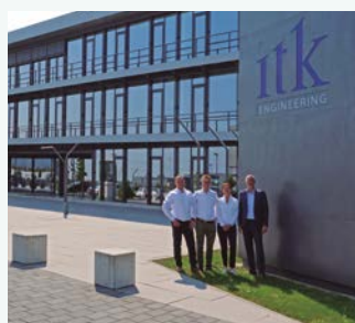
Innovatives Bürogebäude der ITK Engineering GmbH, Deutschland. ECOi und PACi
