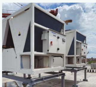
Gebäudekomplex CÉDRUS LIGET mit eleganten Apartments, Penthousewohnungen, Geschäften usw., Ungarn. ECOi-W, ECOi und PACi
