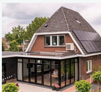
Aquarea T-CAP Wärmepumpe als Komplettlösung für Heizen, Kühlen und Brauchwarmwasserbereitung in einem luxuriösen Eigenheim. Voorthuizen, Niederlande. Aquarea
