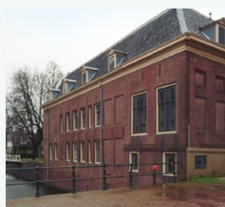
Klimatisierung eines historischen Gebäudes am Amsterdamer Marineterrein, Niederlande. ECOi-W
