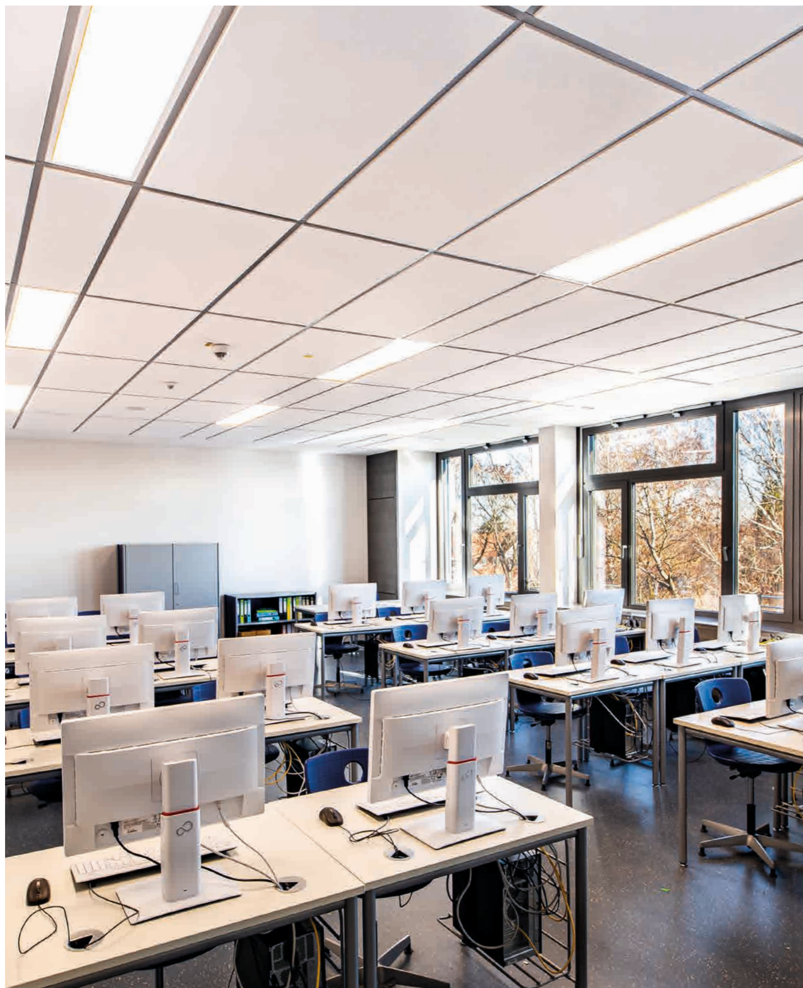
Mineraldecke Sinfonia, System S 3, T24-Sichtschiene schwarz Mittelschule Dachau, Deutschland
