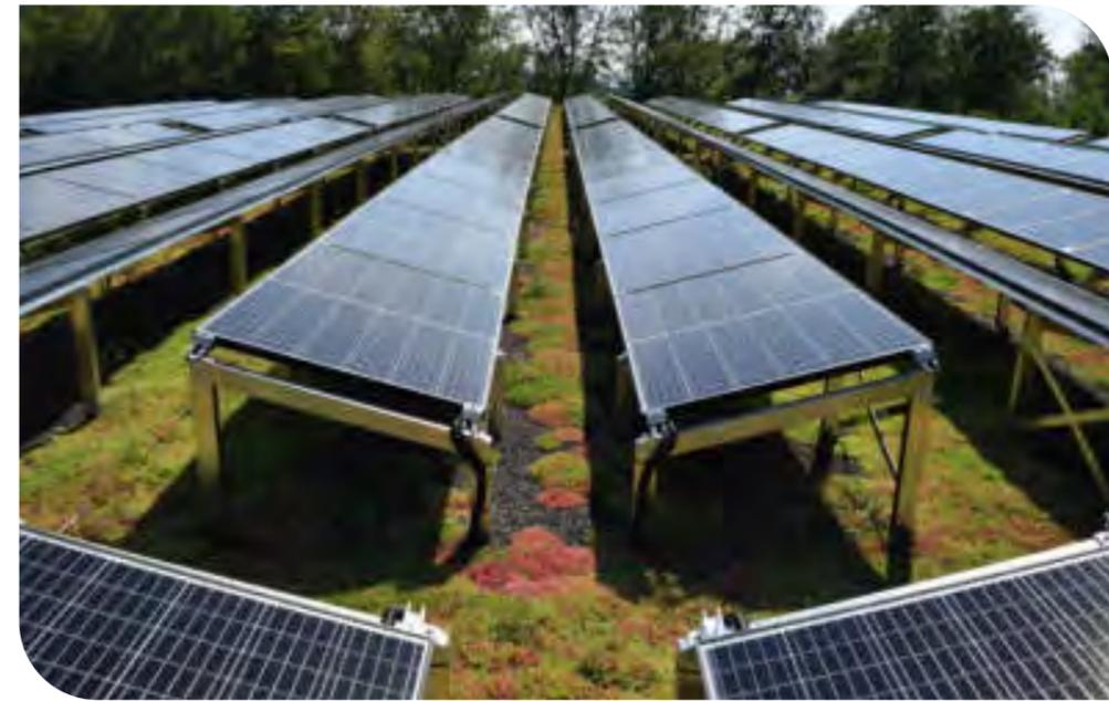
OPTIGRÜN-SOLAR ist eine auflastgehaltene Solaraufständerung, die durch den Gründachaufbau lage- und windsog sicher fixiert wird. Für die Installation des Systems ist keine Dachdurchdringung notwendig, es fallen damit keine Dachabdichtungsarbeiten an. Damit wird die Anfälligkeit für Leckagen auch deutlich reduziert.
