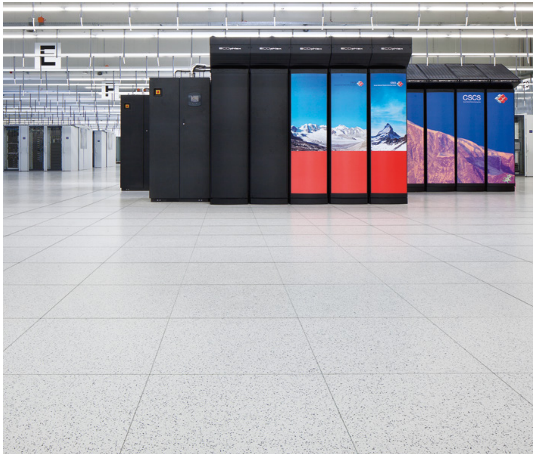
Bauherr: ETH Zürich, Abteilung Immobilien, Zürich Architekt: Itten+Brechbühl AG, Zürich Produkt: noraplan® astro ec, ca. 2.800 m 2 Einsatzbereich: Rechnerräume Fotos: © Marco Abram
