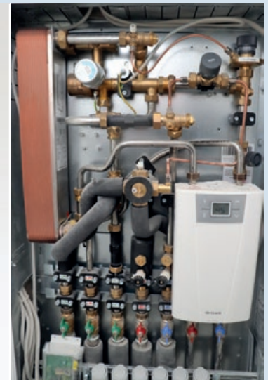
Das Herzstück der Heizung und Warmwasserverteilung: Die Clage-Übergabestation mit Plattenwärmetauscher, Durchlauferhitzer und Heizkreisanbindung für die Fußbodenheizung.
