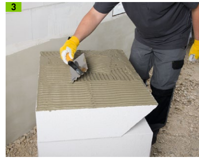
3 Multipor Dichtschlämme mit 12 mm-Zahntraufel vollflächig auftragen
