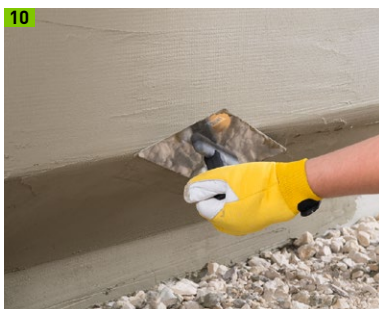
10 Armierungsschicht abziehen und 24 Stunden trocknen lassen
