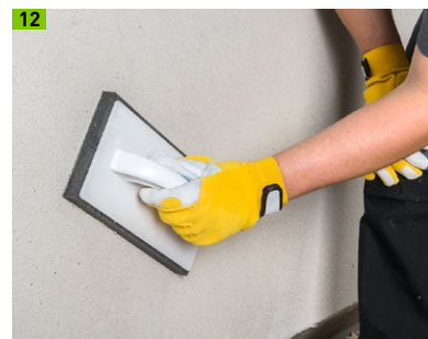
12 Oberputz filzen oder strukturieren
