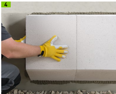
4 Multipor Sockeldämmplatte andrücken und einschwimmen
