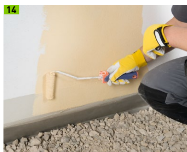
14 Sockel mit wasserabweisender Farbe anstreichen
