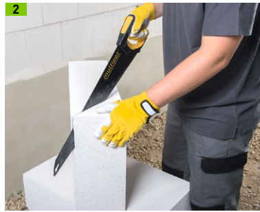
2 Multipor Sockeldämmplatte schräg zuschneiden
