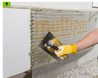
9 Multipor Armierungsgewebe auflegen und einputzen
