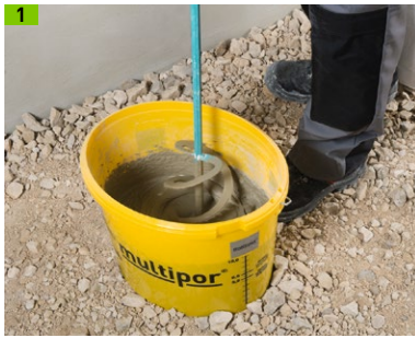
1 Multipor Dichtschlämme anmischen
