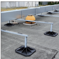
Gummiauflage durch Gummikeil ersetzt
