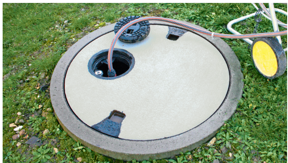
Entnahmestelle Fontana M in der Abdeckung integriert
