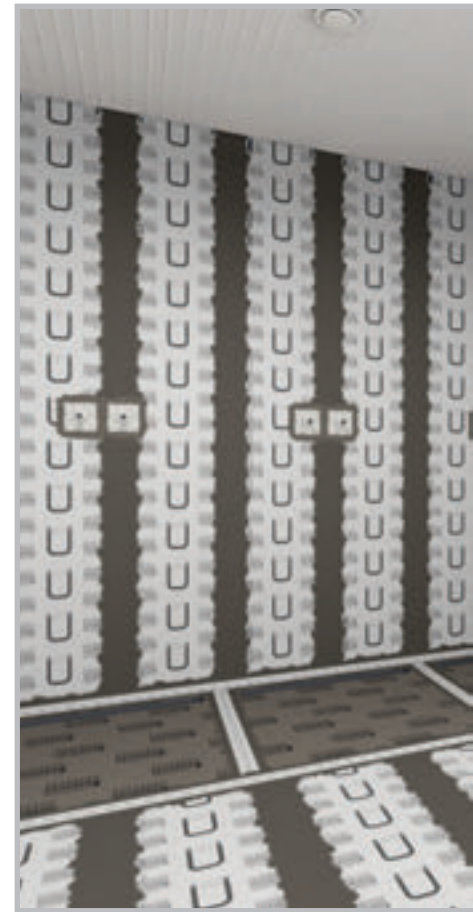
Duschbereich mit bahnenförmiger Abdichtung
