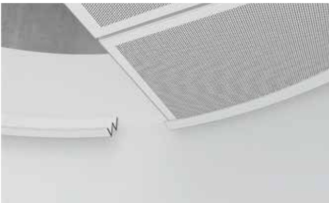
Stufenwandprofil konkav (nach innen gebogen)
