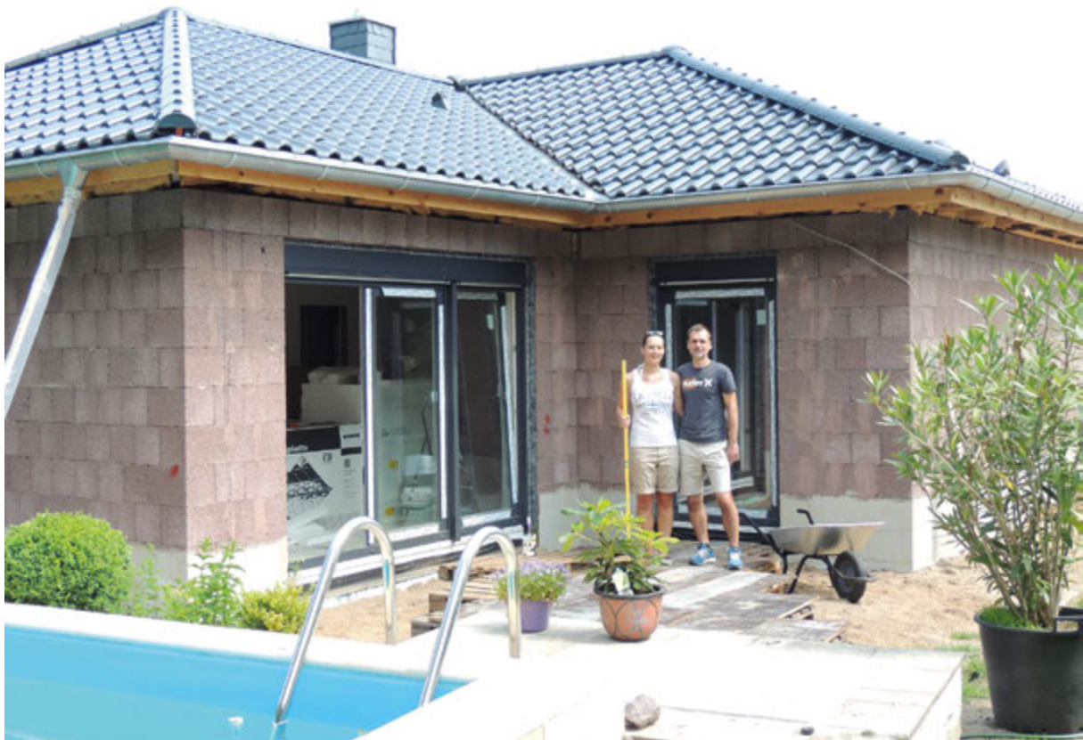
Abbildung: Rohbau im Bungalow-Stil
