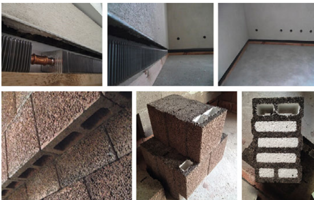
LIAPLAN®- Hypokausten-Klimawandsteine Neubau, Sockelheizregister unter Klimawand
