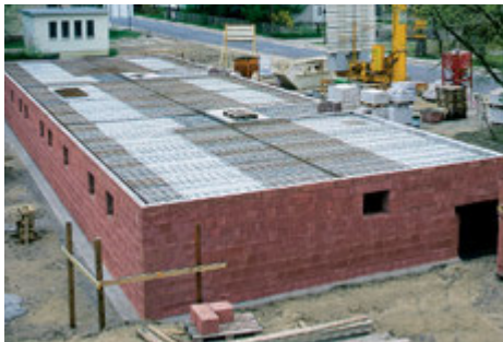
Kellermauerwerk aus LIAPLAN®
