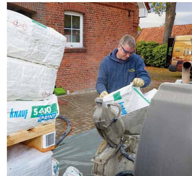
Knauf S 400 Sprint kann effizient maschinell verarbeitet werden.
