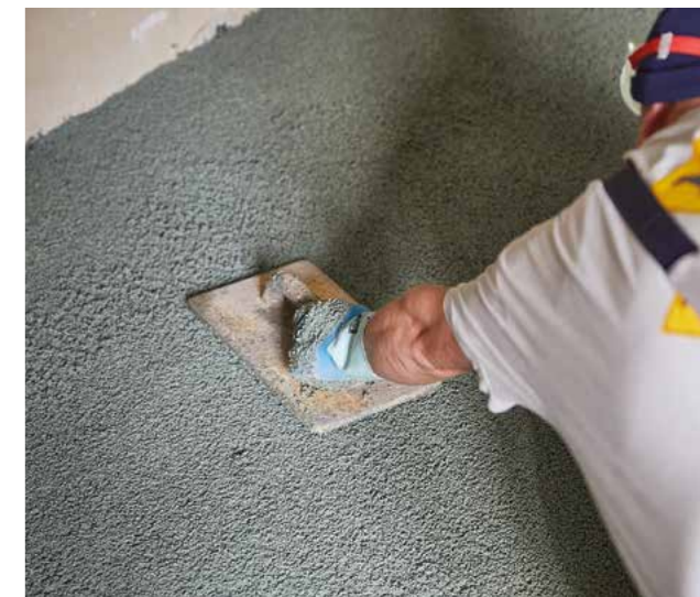
Der zementgebundene Knauf S 400 Sprint beim Einbau.
