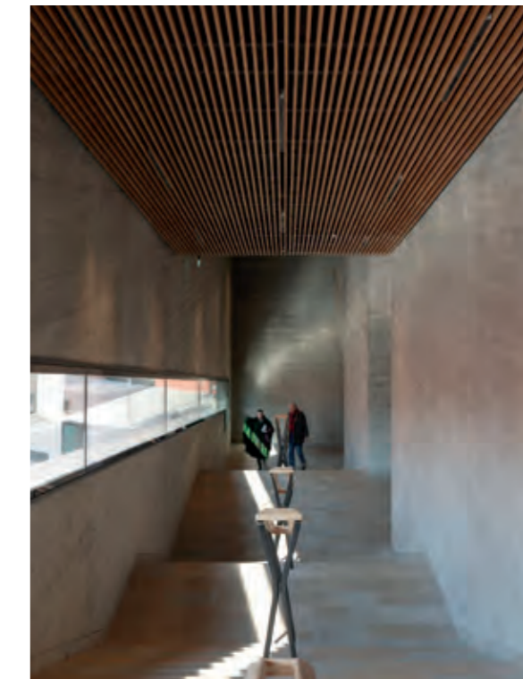
▲ Eine imposante Kaskadentreppe aus rauem Sichtbeton führt die Besucher in die Ausstellungsräume in den oberen Geschossen. In die fein strukturierte Holzlamellendecke wurden INDUL N Schlitzdurchlässe von Kiefer integriert. Sie sorgen auch bei großem Besucherandrang für konstante Raumluftwerte. Fotos © janbitter.de
