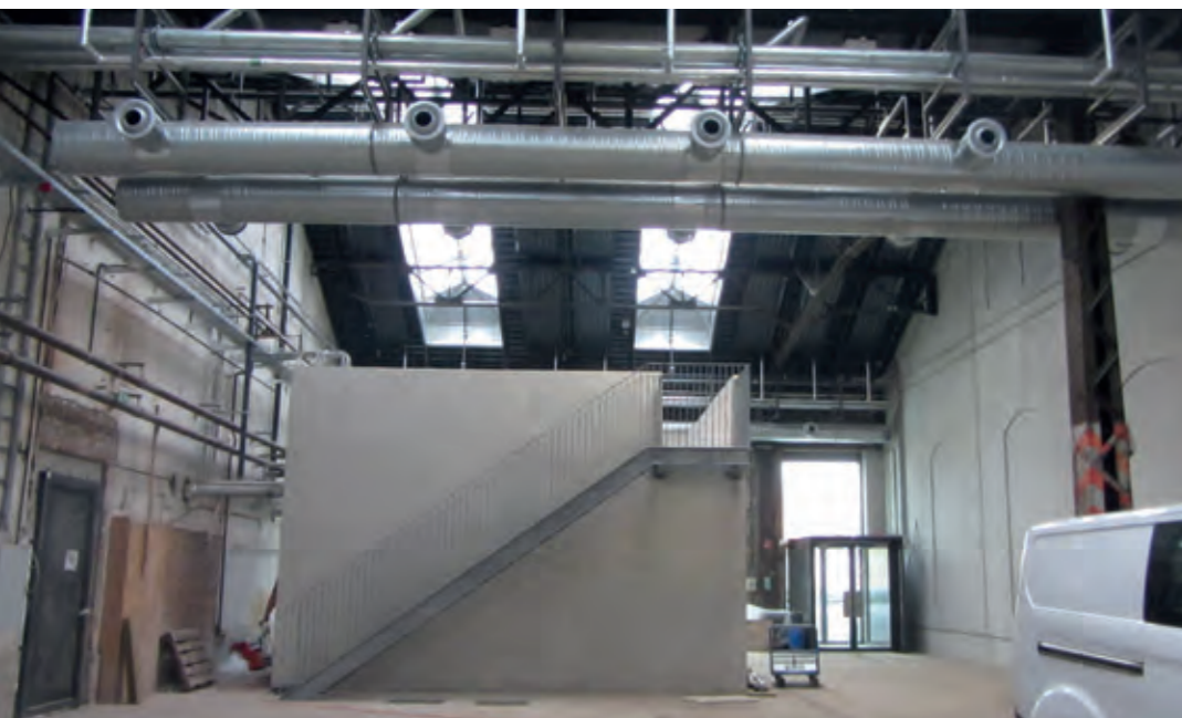
▲ Neue Einbauten wie die WC-Anlagen wurden als graue Kuben respektvoll vom Bestand abgerückt.
