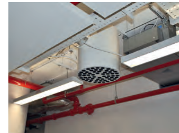
▲ Die Vielzahl unterschiedlicher Designvarianten, Formen und Farbgebungen des INDUDRALL ermöglichen architektonisch kreative Akzente. Eine Montage ohne abgehängte Decke ist aufgrund des hohen Induktionsverhältnisses problemlos möglich.
