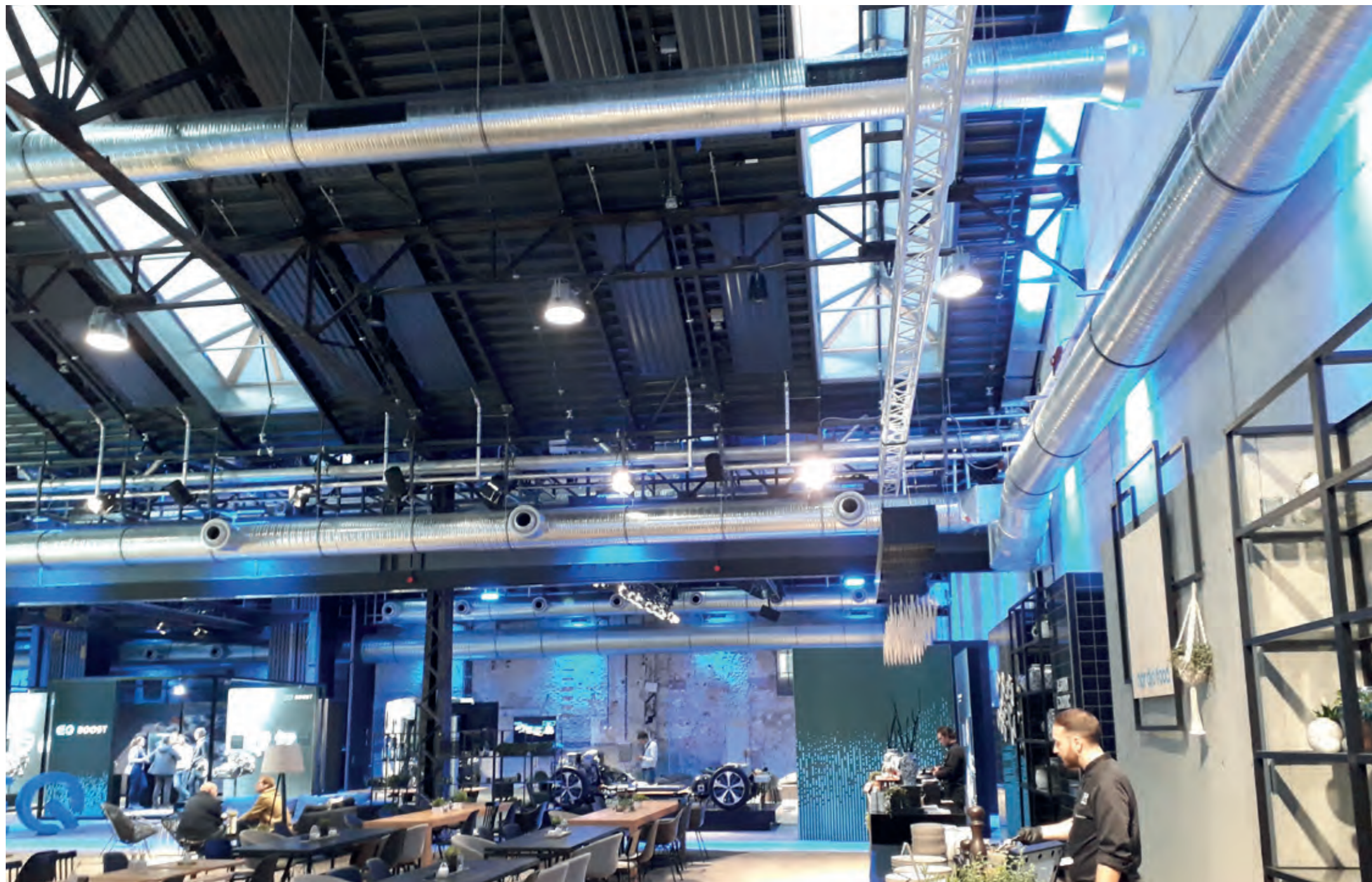
▲ Heute sind die sanierten Wagenhallen eine beliebte Off-Location in Stuttgart mit Gastronomie-Bereich.
