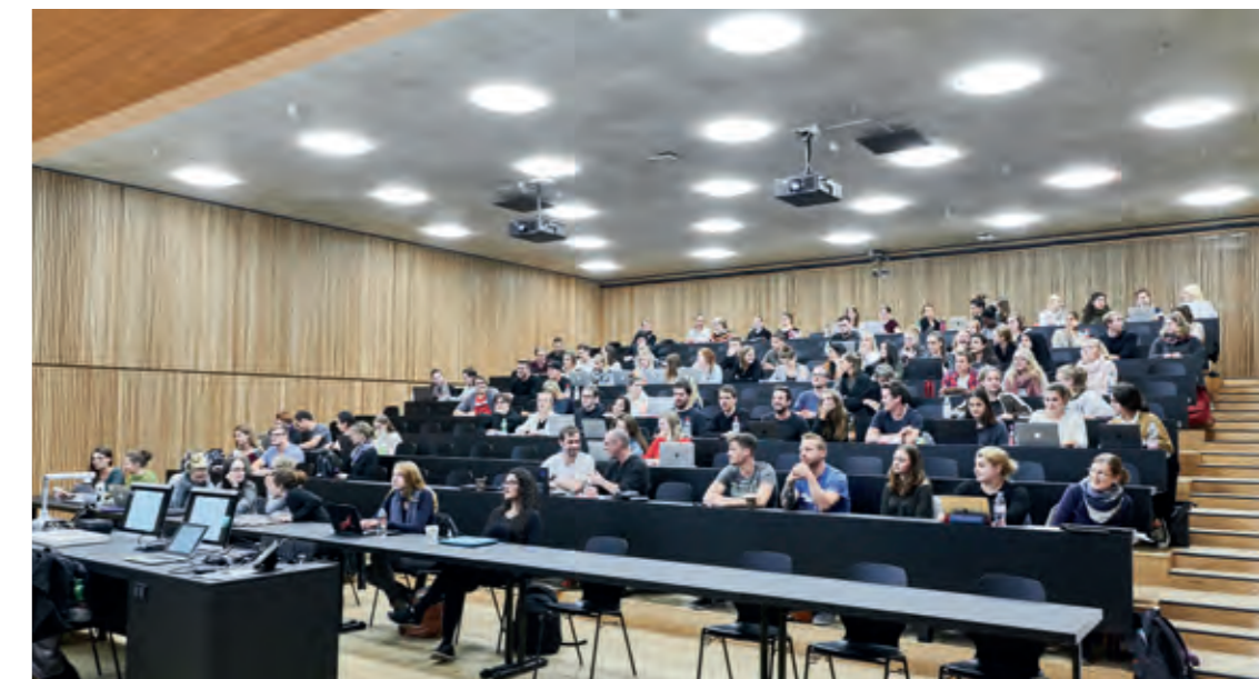
▲ Die Leichtbauwände der 16 Hörsäle sind durch Akustikpaneele mit vertikalen Leisten verkleidet. Die Überströmelemente gewährleisten die freie Überströmung der Luft vom Inneren des Hörsaals in den Flur.
