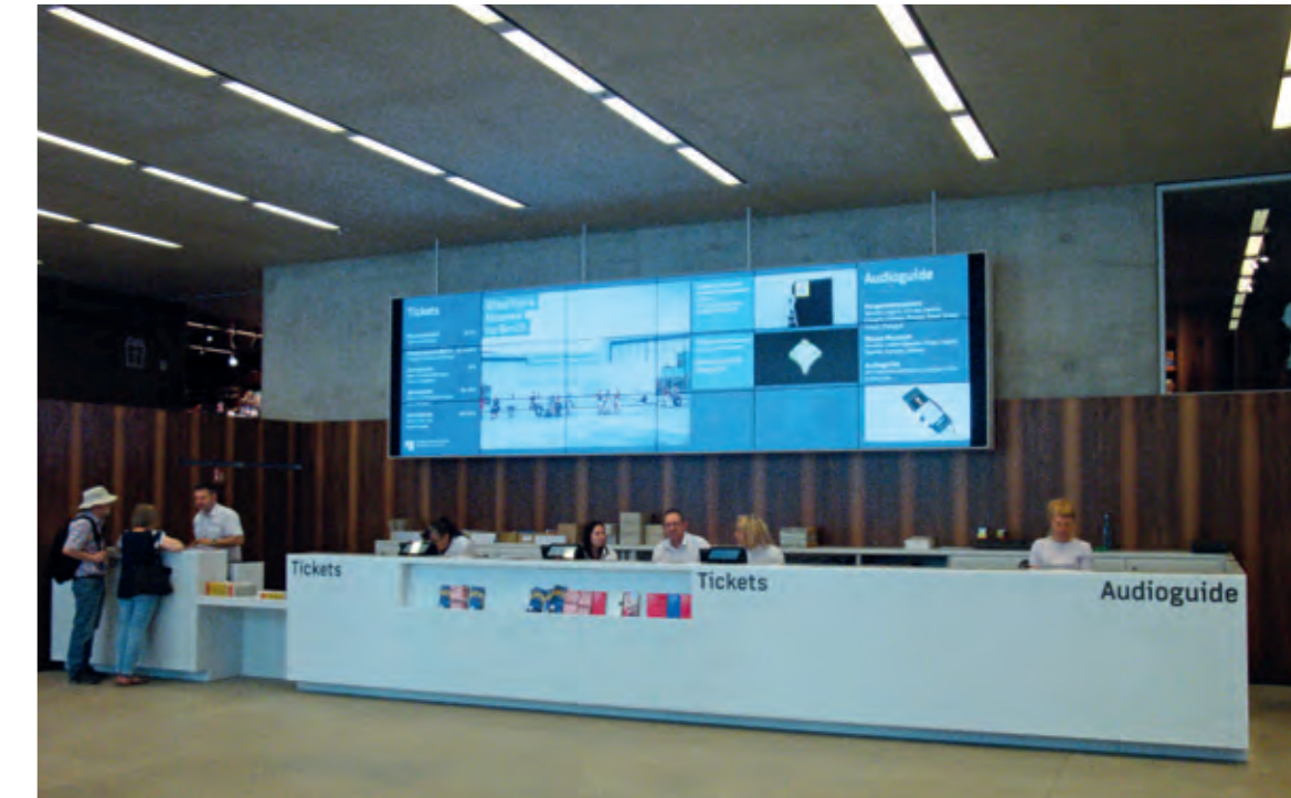
▲ Blick auf den Empfangstresen des Besucherzentrums, mit dem in die Wand eingelassenen, unsichtbar integrierten Wand-Luftdurchlass INDULSNAP, hinter dem Tresen.
