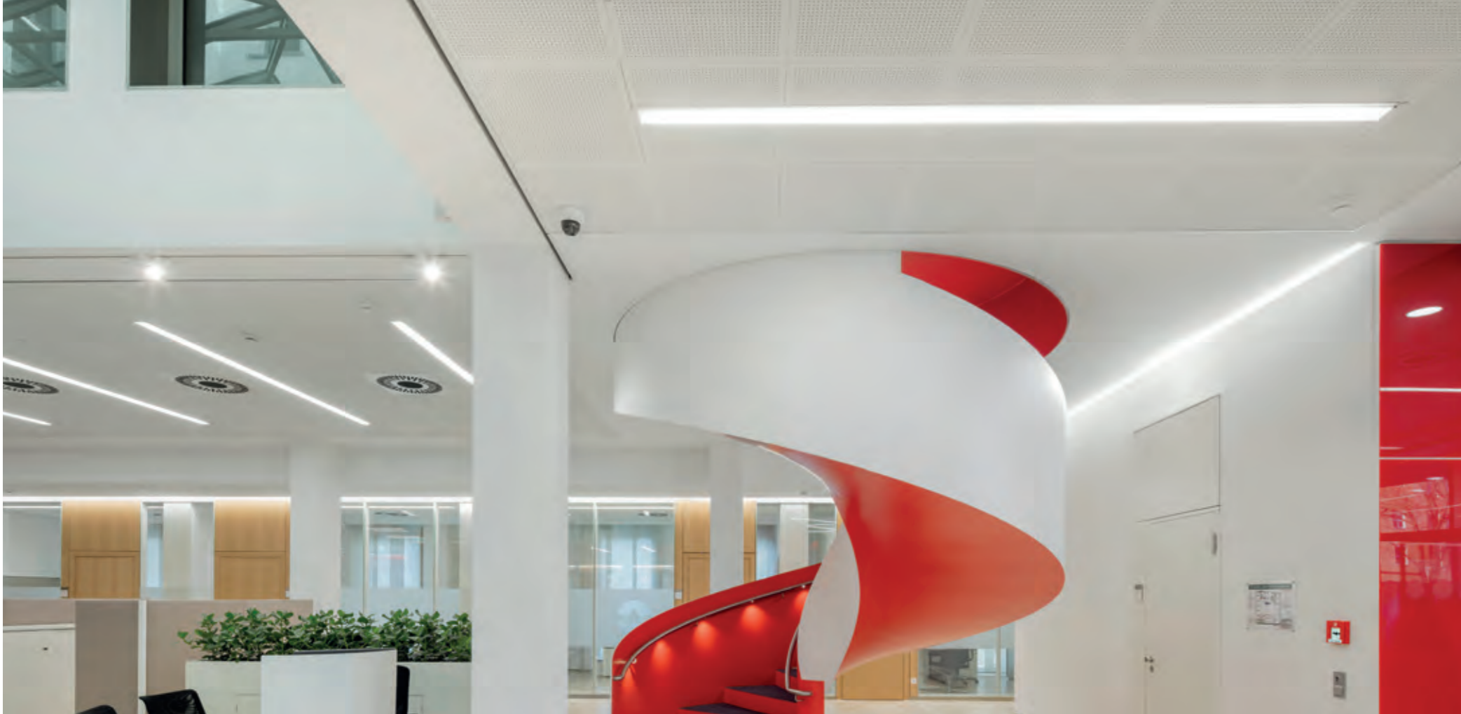
▲ INDULVENT ec in Kombination mit der Deckenbeleuchtung Eingangshalle Sparkasse Bayreuth. Foto © Gerhard Hagen
