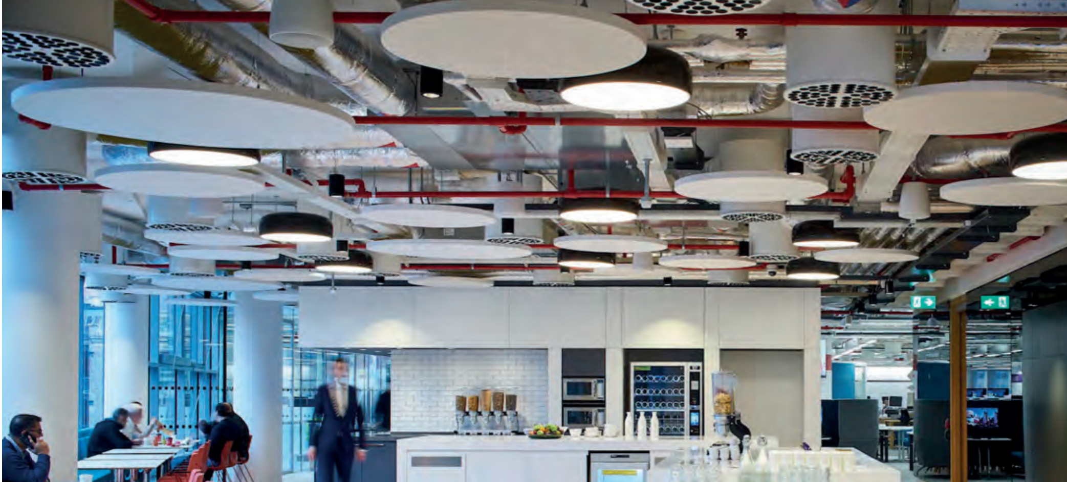
▲ Der Bauherr entschied sich für offene Decken und eine Sichtmontage der Belüftungselemente. Foto © Timothy Soar
