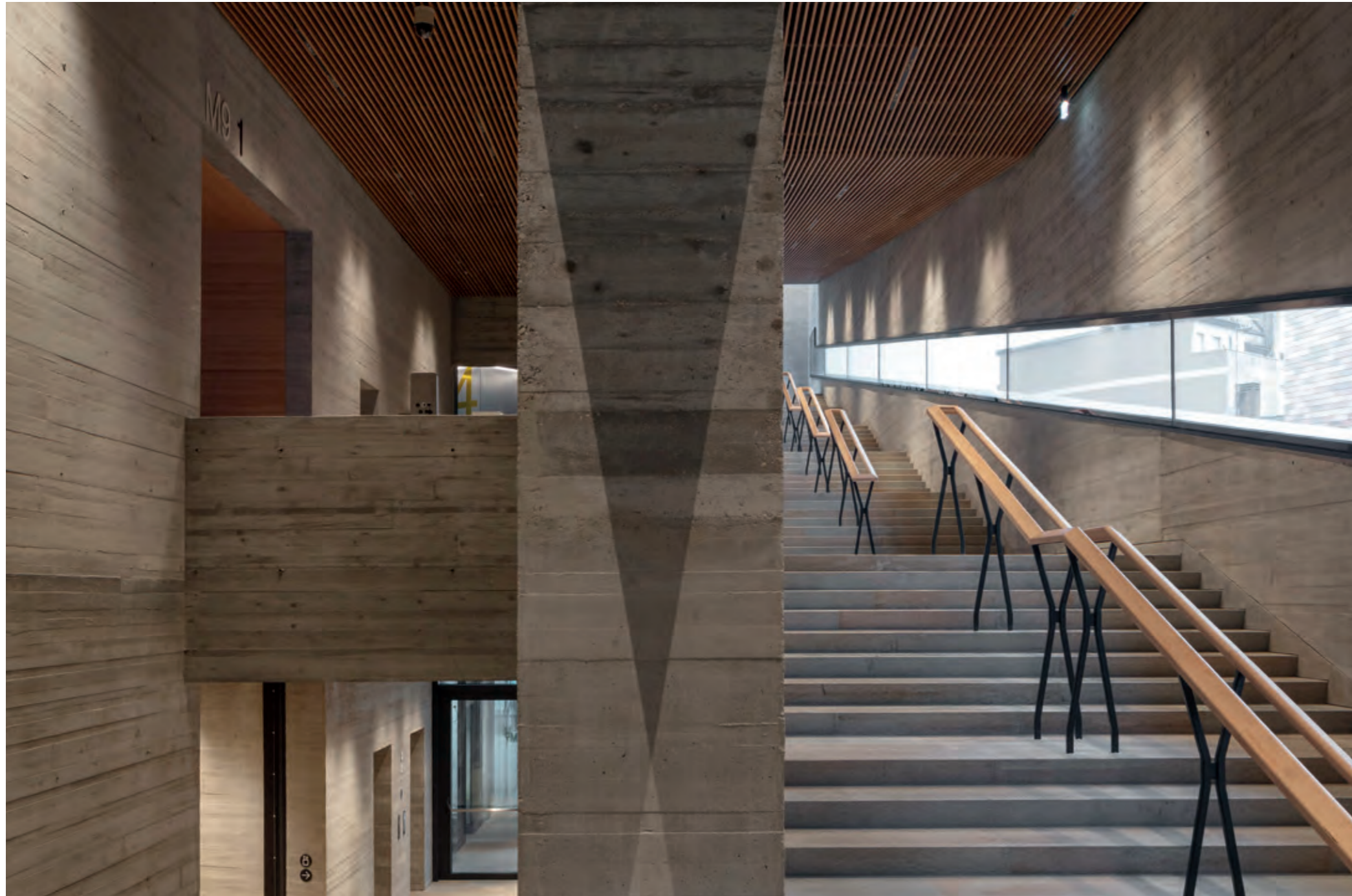
▲ INDUL N Schlitzdurchlässe sind zwischen den fein strukturierten Holzlamellen für die Augen der Besucher unsichtbar. Foto © janbitter.de
