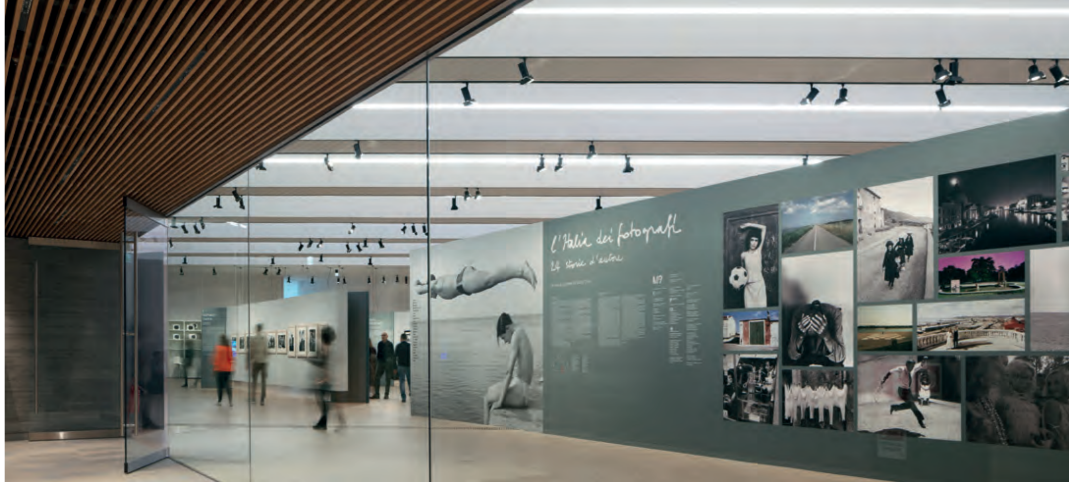
▲ Im 1. und 2. Obergeschoss befinden sich die Räumlichkeiten der Dauerausstellung – hier wurden die INDUL N Schlitzdurchlässe unauffällig in die linear angeordneten Lichtleisten integriert. Foto © janbitter.de
