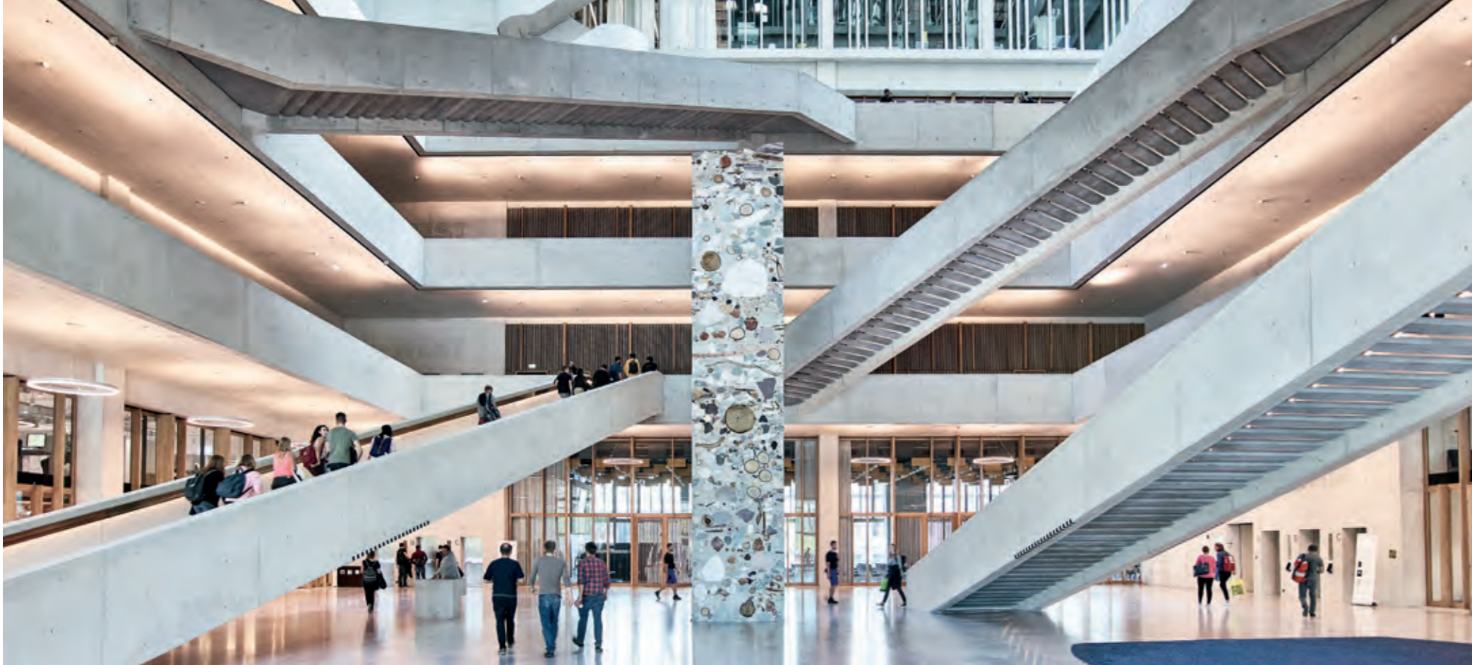
▲ Der offene Luftraum ist wesentlicher Bestandteil des Überströmkonzepts, da es zum Wegführen der Abluft genutzt wird.
