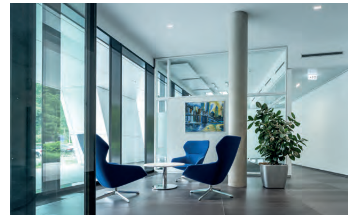
▲ Unauffällige Integration der Luftanschlusskästen in der Flur-Abkofferungen und eine Reihenanordnung der Aluminium-Durchlassprofile im Think Tank. Foto © EgeTrans Internationale Spedition GmbH
