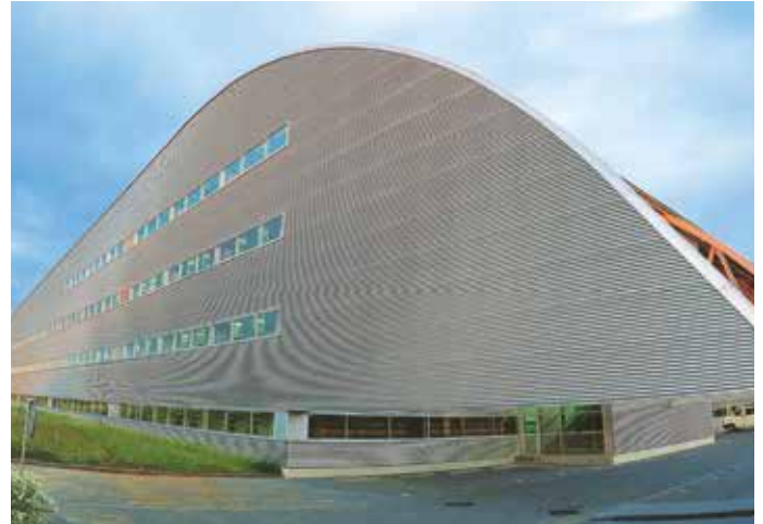
Geschäftsgebäude Würth, Den Bosch (NL) Architekt: De Twee Snoeken
