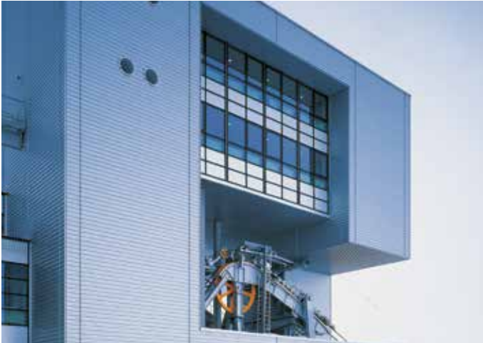
Bergbahnstation, Col du Pillon (CH) Architekt: Mario Botta
