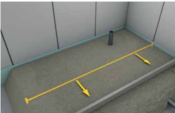
10. Ziehen Sie nun die Fläche mit einer Aluminiumplatte auf der gewünschten Höhe ab.
