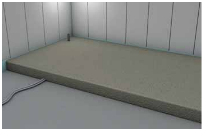
11. Die Dämmung ist nun fertig und in 24 Stunden belegereif.
