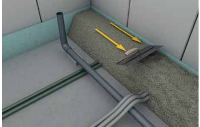
7. Ziehen Sie mit einer Glättkelle und einer Aluminiumplatte eine waagrechte Lehre, auf der Sie im Anschluss abziehen können.
