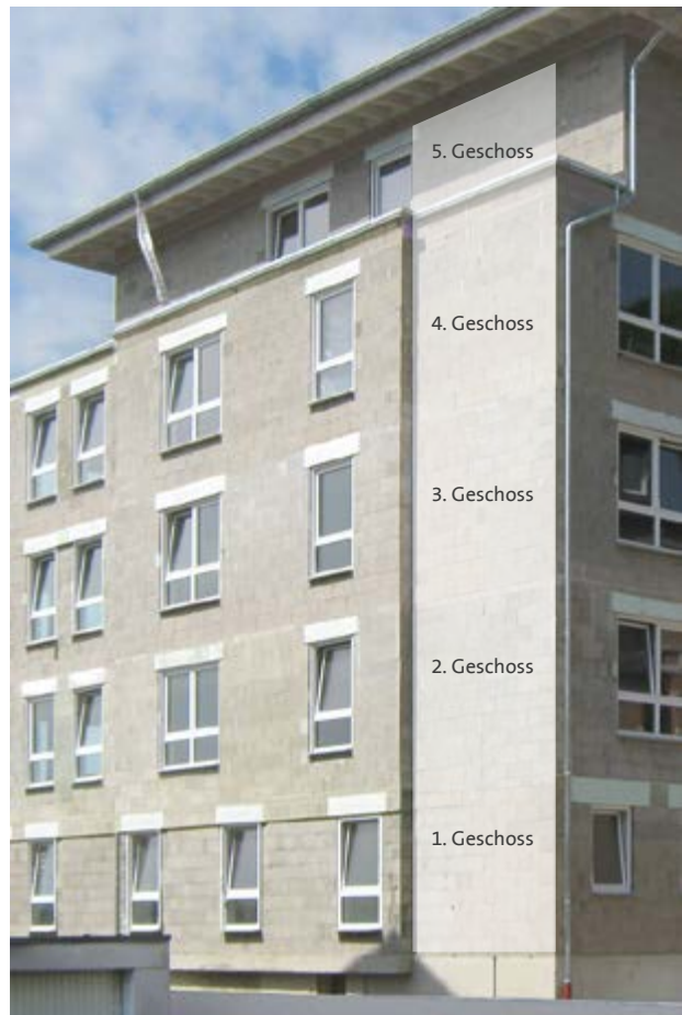
5-geschossiges MFH in Rheinland-Pfalz
