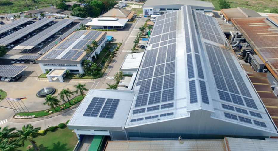
Auf dem Dach des Werks in Klaeng sind Solarzellen montiert. Das senkt den CO 2 -Ausstoß um nahezu 2000 Tonnen im Jahr.
