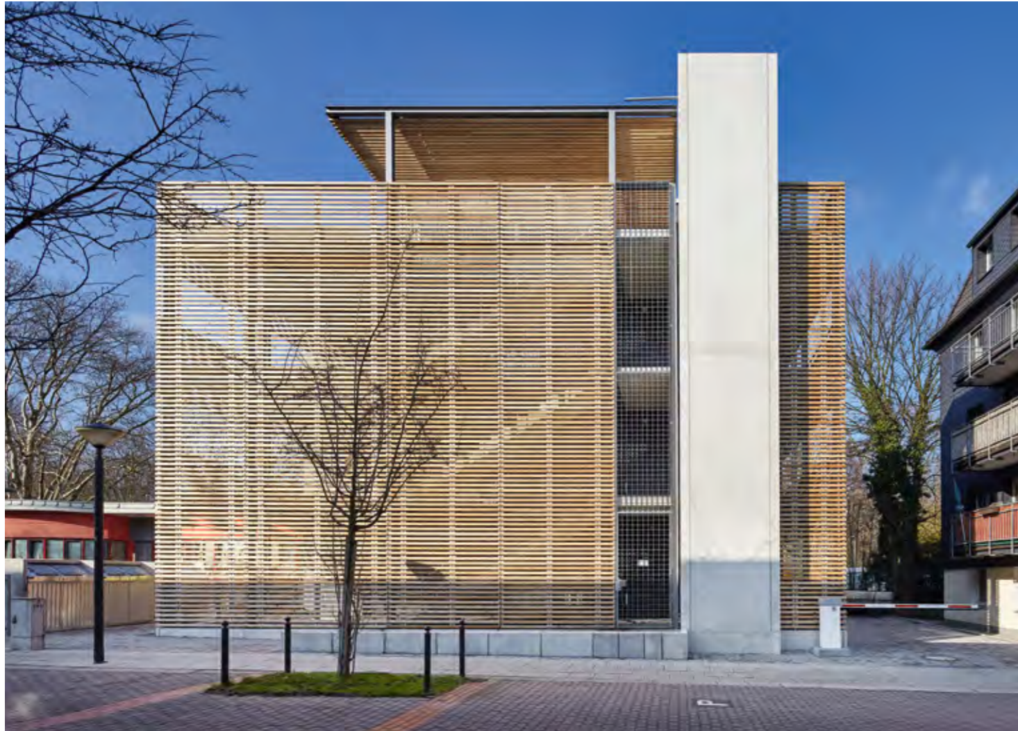
Das ehemalige Gemeindehaus wurde in einen attraktiven Lebensraum verwandelt. Eine transparente Lamellenstruktur umschließt die außen liegenden Erschließungselemente.
