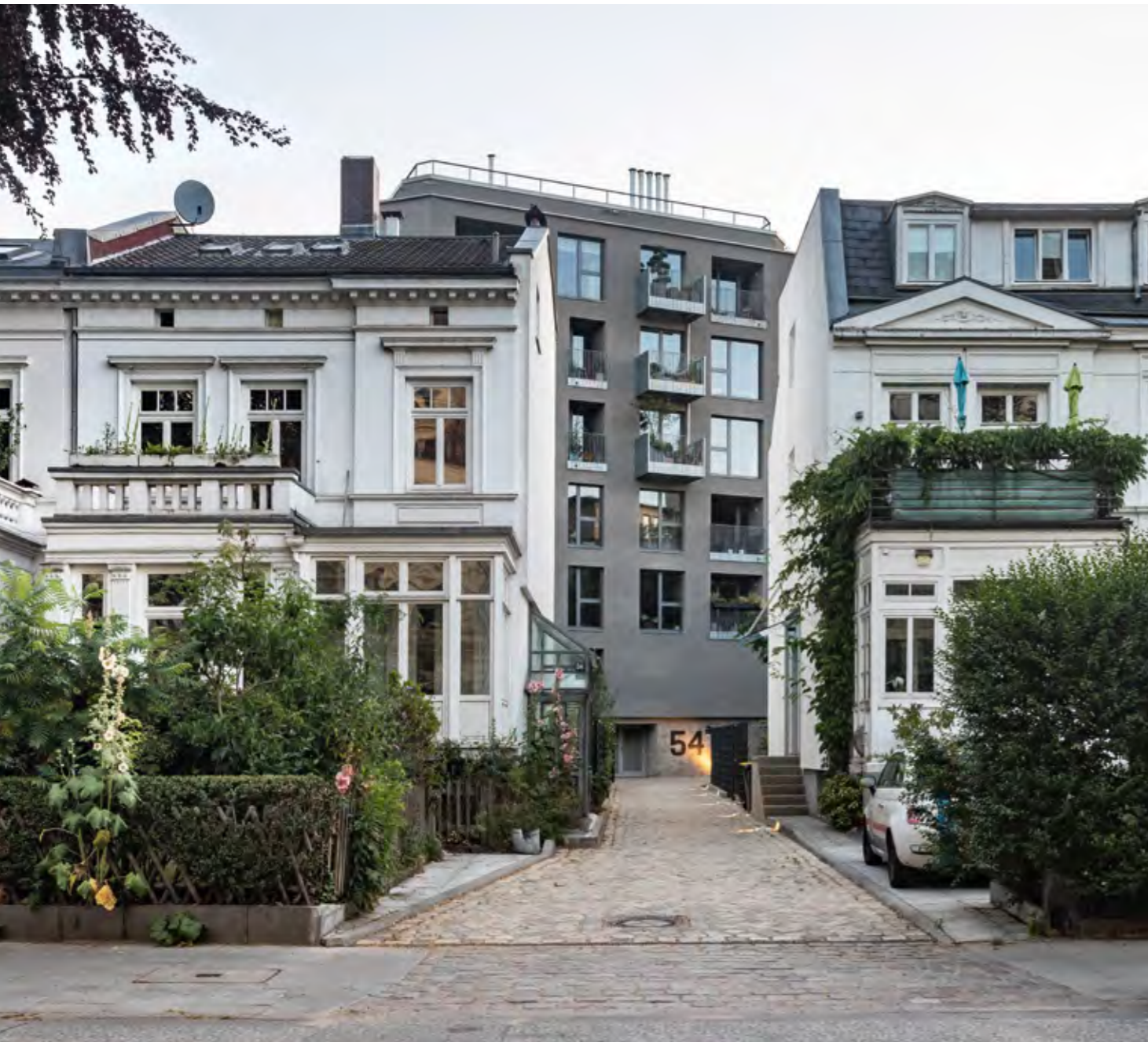
Der Bunker nach dem Umbau durch Architekt Björn Liese: Auf sechs Etagen wird gewohnt, die Räumlichkeiten wurden mit bodentiefen Fenstern sowie Balkonen und Loggien versehen.
