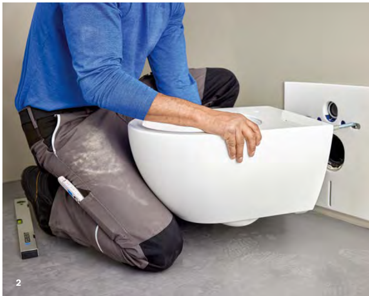
1 Das Wandfixierungselement (blau) mit integrierter EFF3-Befestigung. 2 Keramik auf die Stockschrauben aufschieben. 3 Von oben über die Löcher zur Sitzbefestigung Schraube per Inbusschlüssel anziehen, das Schneckengetriebe zieht die Keramik fest an die Wand.
